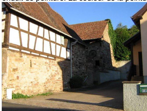
La structure des bâtiments anciens : grès et colombages (août 2015)
