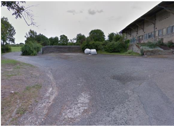
Photo 1 : accès à l'arrière du bâtiment
