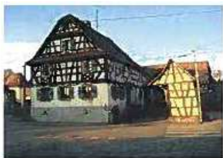
Photo 2 : Maison type vers 1800 à Keffenach Mommelshoffen
