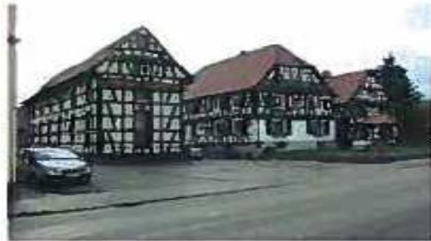
Photo 4 : Grange-séchoir à tabac à Surbourg
