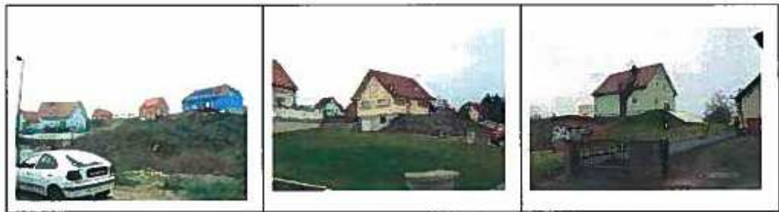
Figure 43 : Assemblage indiquant le non-respect de la topographie
