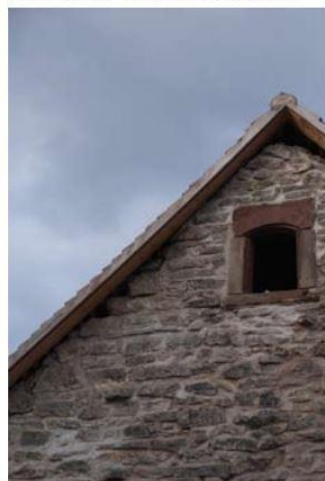
Tuiles scellées au mortier à la chaux + planche de finition
