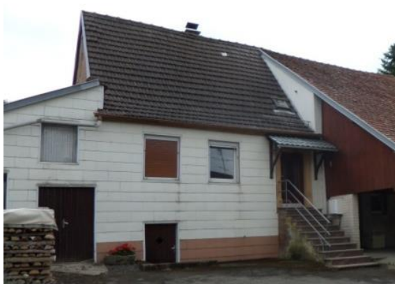
Isolation par l'extérieur, disparition des modénatures en grès
