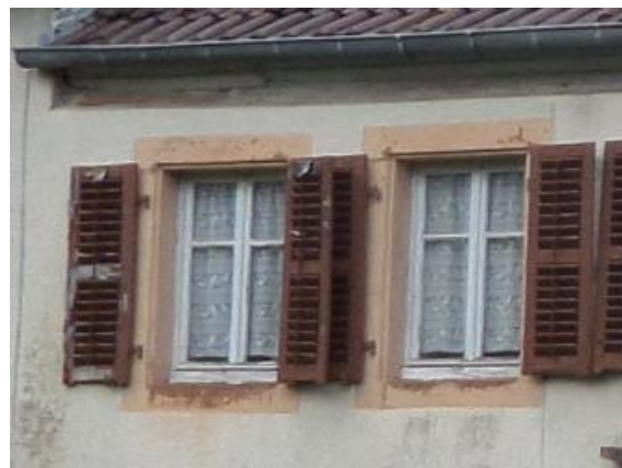
6 carreaux et petits bois, volet à panneaux partie basse et à persienne partie haute 4 carreaux et petit bois, volet à persiennes
