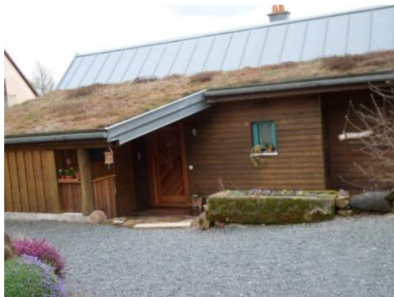
Impasse des Chênes, toiture végétalisée et couverture en aluminium
