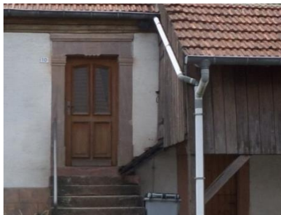
Porte d'entrée en bois à cassette, encadrement en grès travaillé
