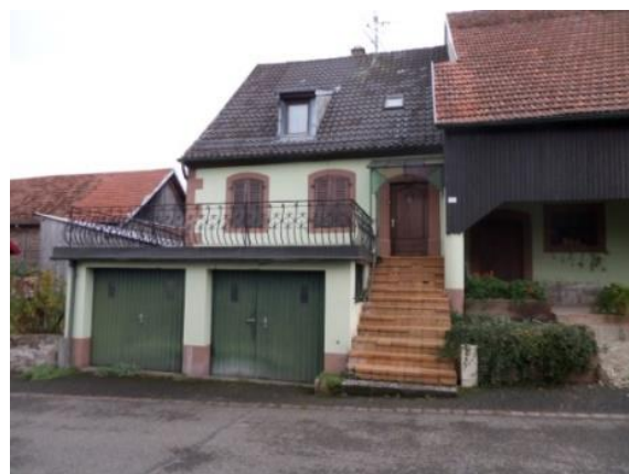
Extension sur l'emprise de l'usoir
