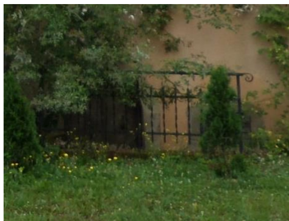
Garde-corps en fer forgé
