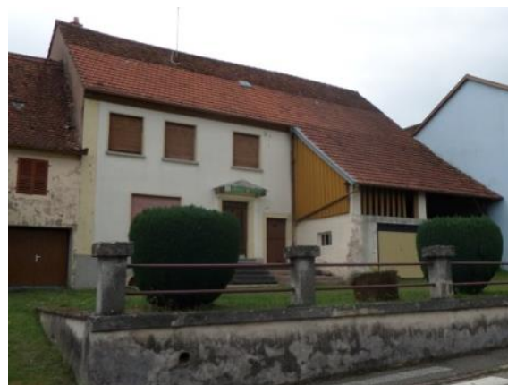
Modification des proportions des ouvertures, disparition des encadrements en grès
