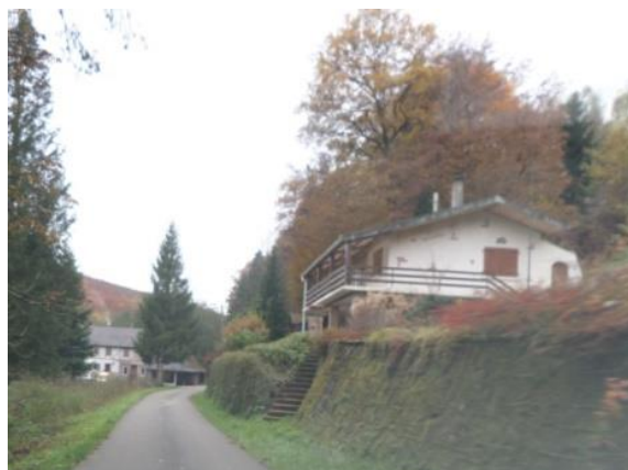
Résidence secondaire, rue du moulin
