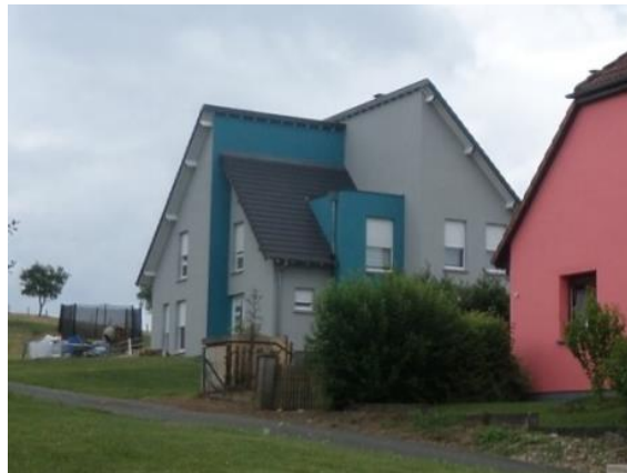
Rue Principale, formes de toitures complexes
