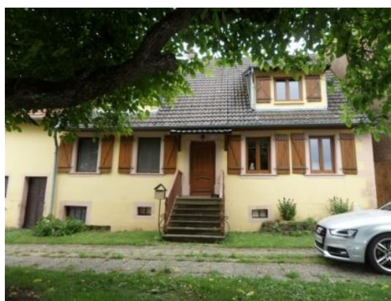
Création de lucarne sans respect des alignements et des proportions du bâti ancien
