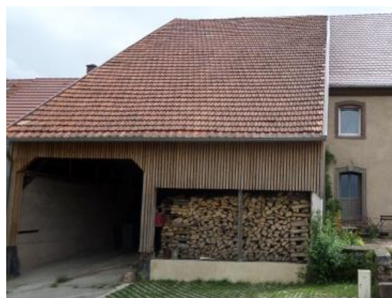
Schopf rénové, remplacement du lattage
