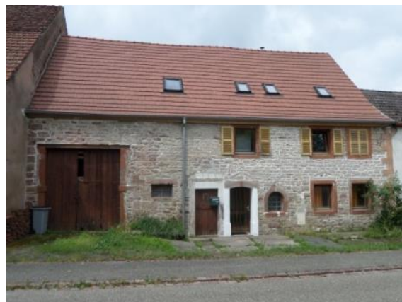
Aperçu des murs en moellons en attentes du crépissage
