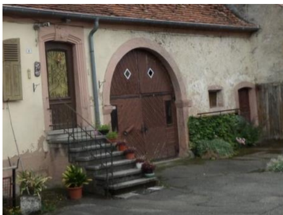
Garde-corps en fer forgé
