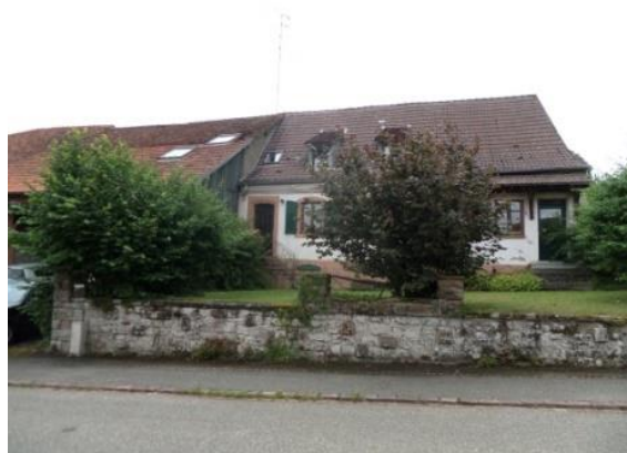
Muret de soutènement en pierre apparente
