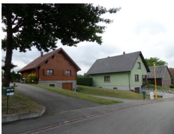
Extension spontanée linéaire, rue de l'Eglise
