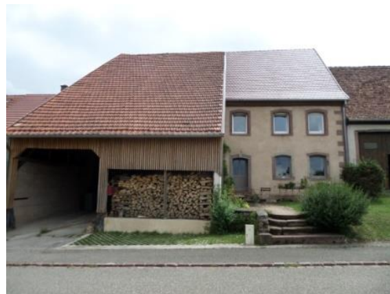
Ferme avec Schopf utilisée pour stockage et stationnement ouvert, rue Principale
