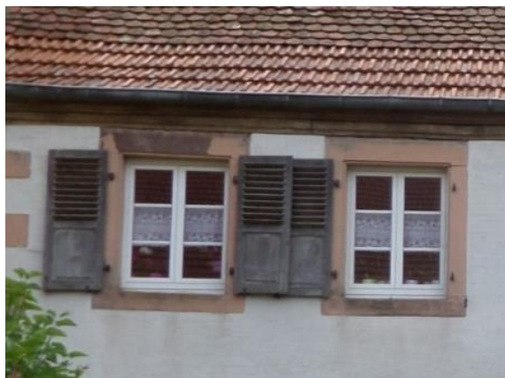
6 carreaux et petits bois, volet à panneaux partie basse et à persienne partie haute 4 carreaux et petit bois, volet à persiennes
