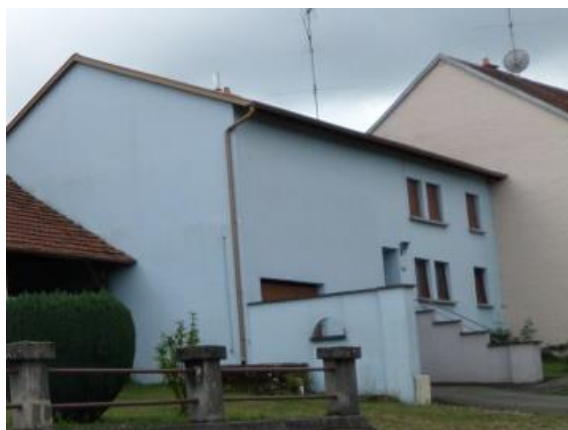
Disparition des encadrements et des modénatures en grès
