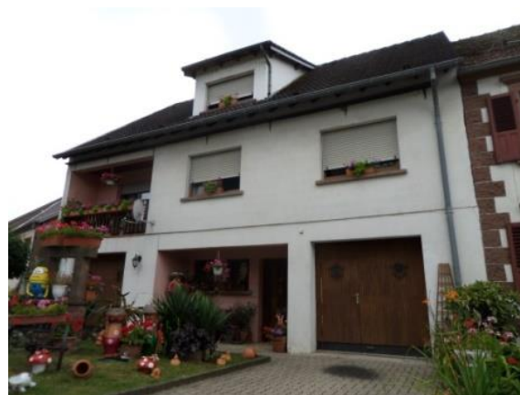
Bâti neuf d'architecture inadaptée au tissu urbain ancien
