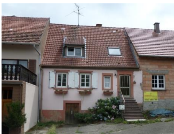
Création de lucarne sans respect des alignements et des proportions du bâti ancien
