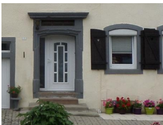
Porte d'entrée avec imposte, menuiserie récente en PVC, volet roulant avec caisson extérieur
