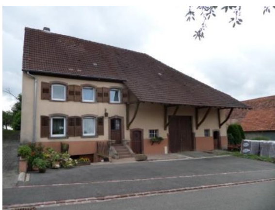
Rue de l'Eglise, débord de toiture pour la partie grange
