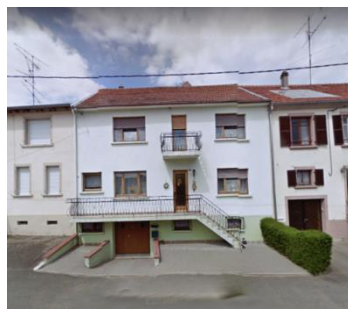
Aménagement en façade d'un stationnement en sous-sol, d'un balcon et d'une course banalisant le tissu urbain ancien
