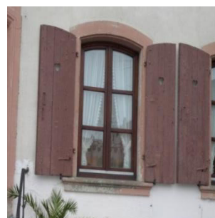
Fenêtre en bois récente
