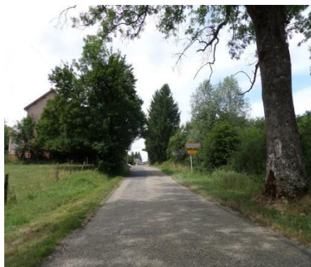
Entrée Sud-Est du village au niveau de la RD123 - Source : OTE Ingénierie
