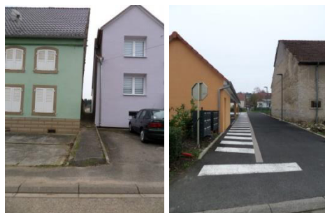
Chemins piétons rue des Alliés et rue du Stade
