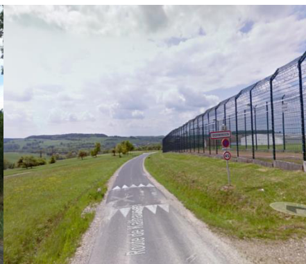
Entrée Est du village au niveau de la RD124 - Source : Google Maps
