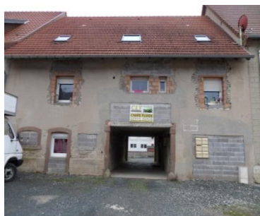
Percement des ouvertures - perte de l'identité du bâti traditionnel
