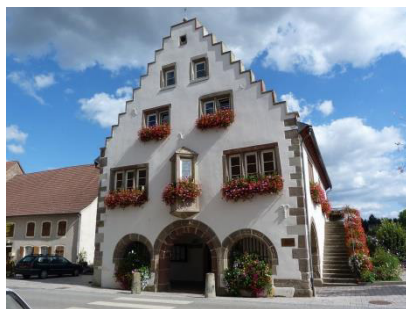
Façade avec oriel et toiture inscrits – Source : OTE Ingénierie
