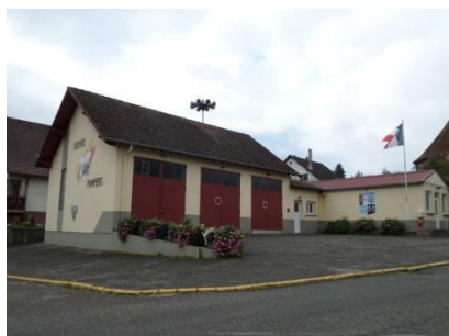
Local des sapeurs-pompiers
