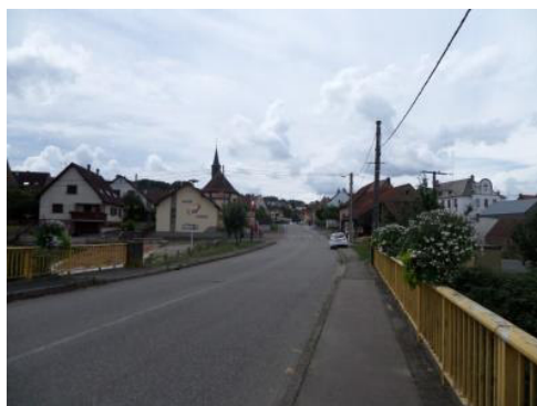
Pont au-dessus de l'Eichel - Source : OTE Ingénierie
