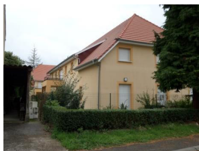
Rue du Stade et rue des Alliés, logements collectifs
