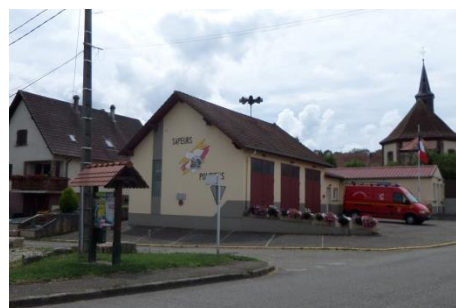
Caserne des pompiers
