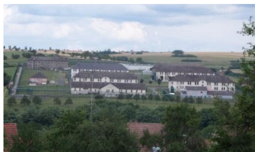
Centre pénitencier – Source : OTE Ingénierie
