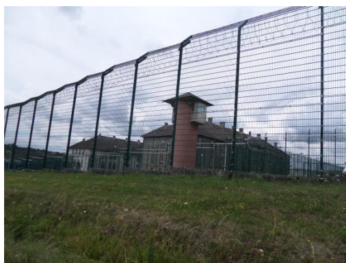
Centre pénitencier - Source : OTE Ingénierie
