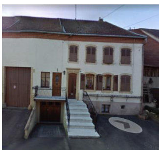
Création d'un balcon et d'accès au sous-sol non adaptée au tissu ancien
