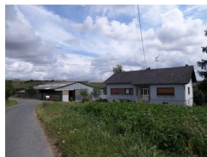
Bâtiment agricole rue de la Ferme
