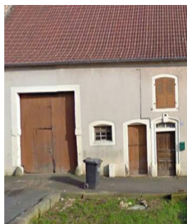
Porte cochère avec linteau droit
