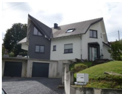
Rue de la Source, maison datant des années 2000
