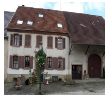
Rue de la Mairie, ferme cossue, dépendance avec un large débord du toit
