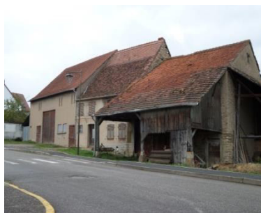
Rue de la Laiterie, dépendance avec un "schopf" traditionnel
