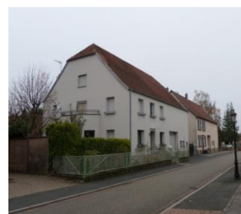
Rue du stade, ferme en reconstruction
