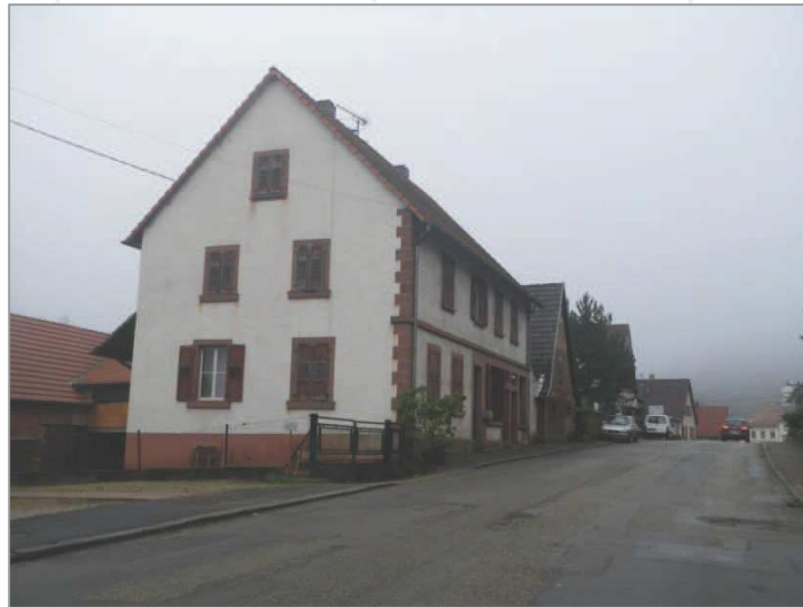
Exemple de maison en pierre (rue Principale)
