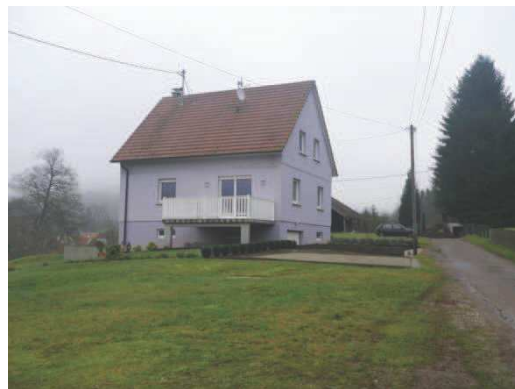
Quelques constructions ont des couleurs plus vives (rue de la Glockengrube)
