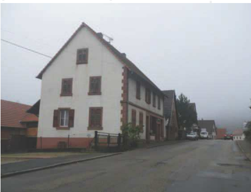
Construction implantée en limite d'emprise publique (rue Principale)
