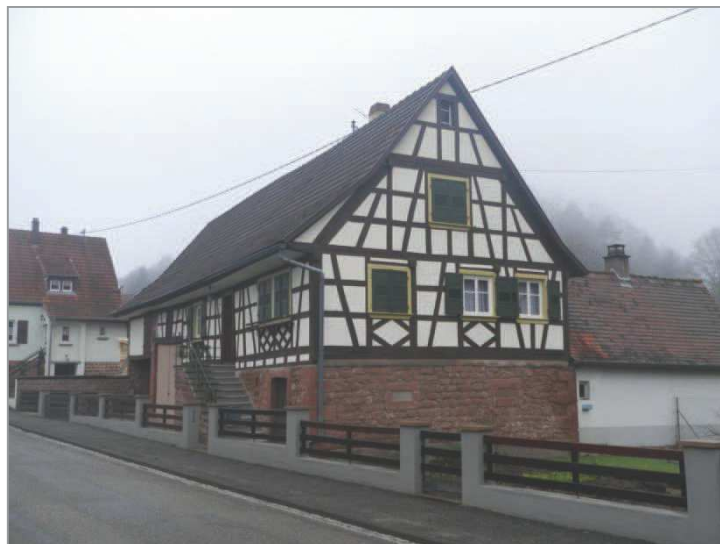
Exemple de maison mixte (rue Principale)
