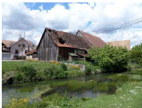
Rue du Général Walter, dépendance qui tombe en ruine
