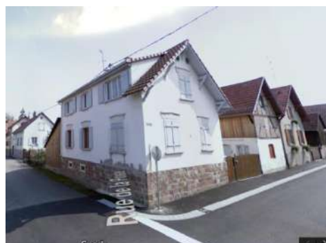
Rue de la Poste, rue Neuve, création de lucarnes non proportionnées par rapport au bâti ancien
