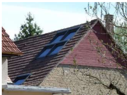
Fenêtre de toit récent sur une ancienne dépendance aménagée en logements
