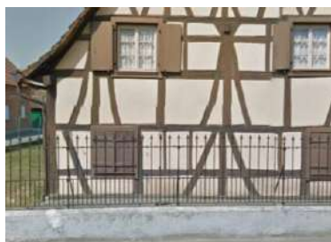
Clôture en fer forgé sur un soubassement maçonné
