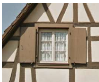
6 carreaux et petits bois, volets à panneaux
