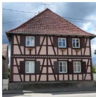
Rue de Strasbourg, toiture à quatre pans
