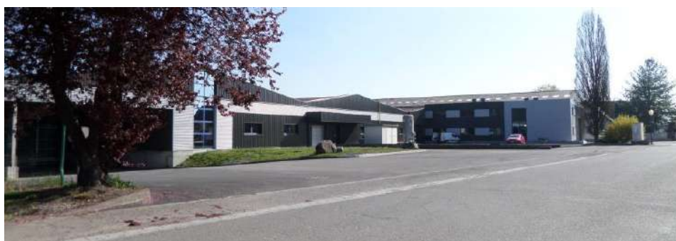
Rue Daubensand, activités font face au bâti pavillonnaire
