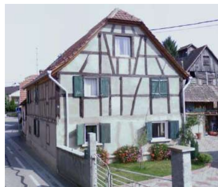
Rue du Daubensand – fenêtres en PVC d'un battant
