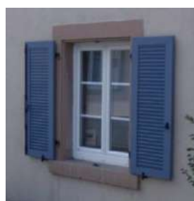
Fenêtres récentes respectant la subdivision en 6 carreaux et petit bois, volets à persiennes
