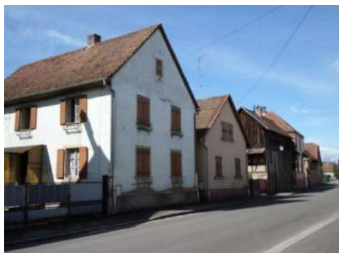
Rue de Colmar, maisons en maçonnerie
