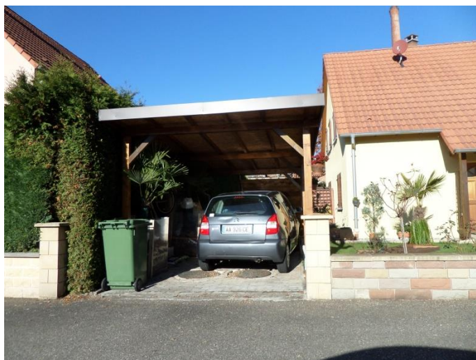
Carport rue des Noisetiers
