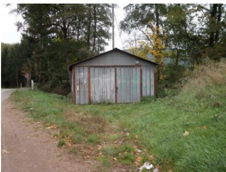
Hangar CD67 au bord de la D392
