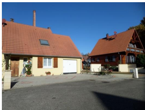
Constructions des années 1990
