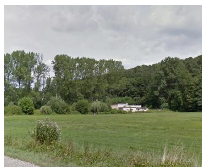
Ancienne centrale à béton
