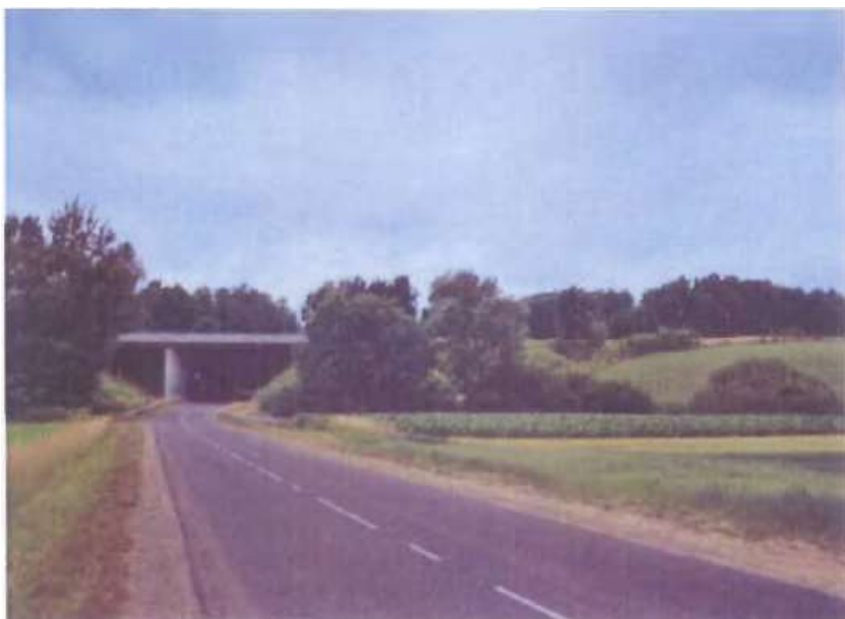
Photo 6 : passage sous l'autoroute au niveau de la D89
