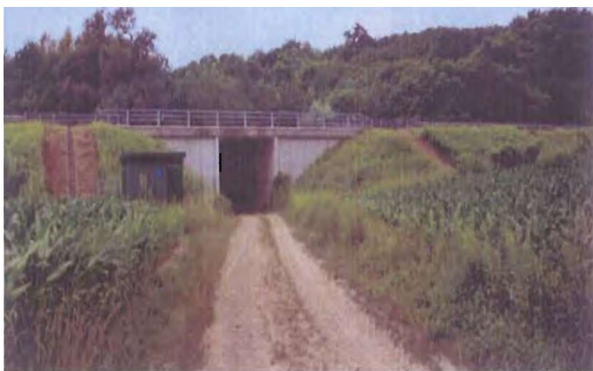
Photo 7 : passage sous l'autoroute au niveau du lieu-dit le Reizel
