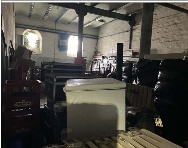
Photographie 25 : RDC – Pièce de 130 m 2 (Ancien stockage de matières brassicoles?)
