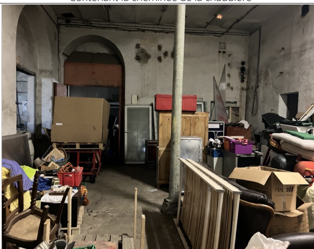
Photographie 24 : RDC – Pièce de 75 m 2 (Ancien stockage de matières brassicoles?)
