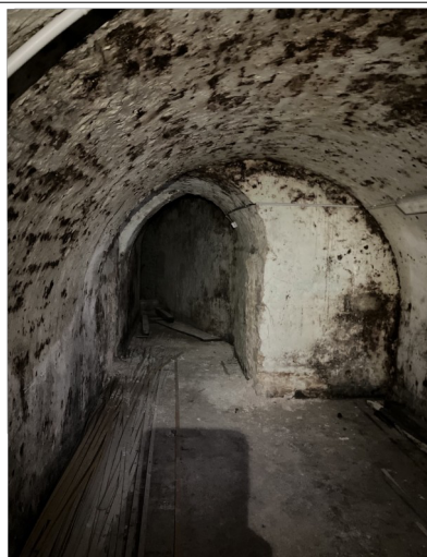
Photographie 42 : N-2 Extension ouest Pièce 86 m 2
