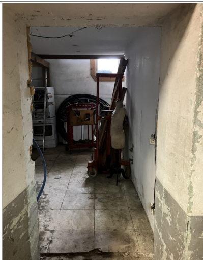
Photographie 19 : RDC – Entrée sud de la pièce de 35 m 2
