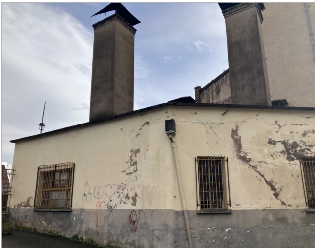
Photographie 3 : Vue vers le sud du nord du site
