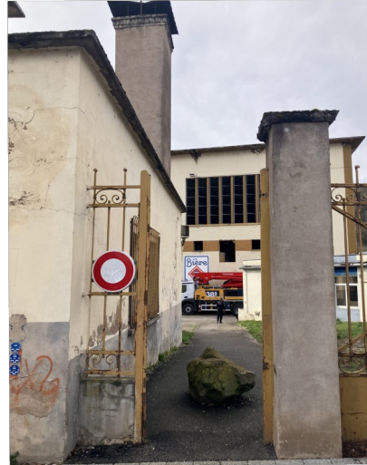
Photographie 2 : Vue vers l'ouest du nord du site
