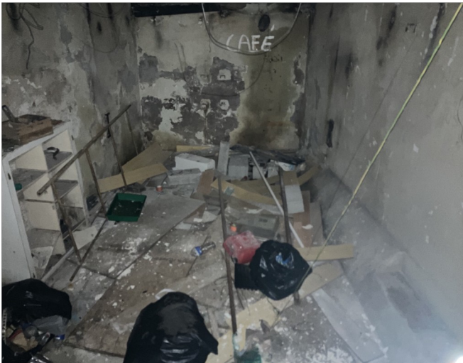
Photographie 15 : Sous-sol sous la pièce de 56 m 2 , Partie sud de l'extension ouest
