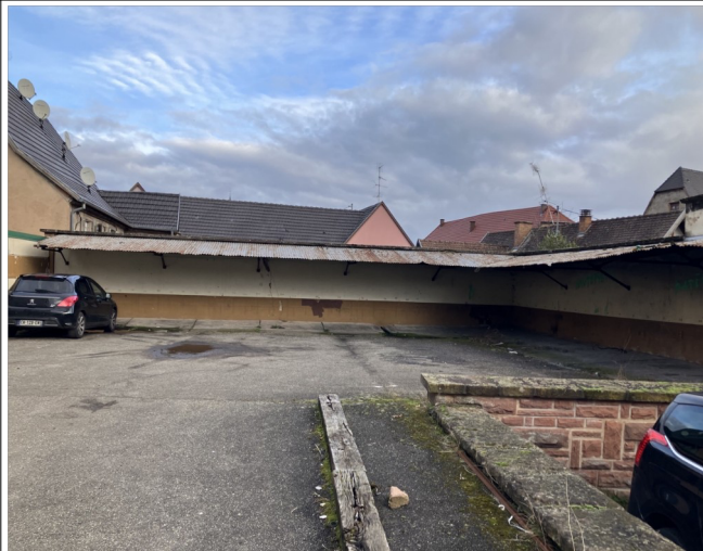
Photographie 10 : Vue vers l'est de la partie sud du site
