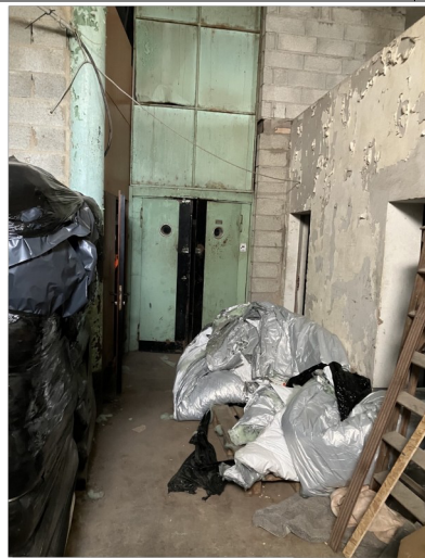
Photographie 26 : RDC – Monte-charge
