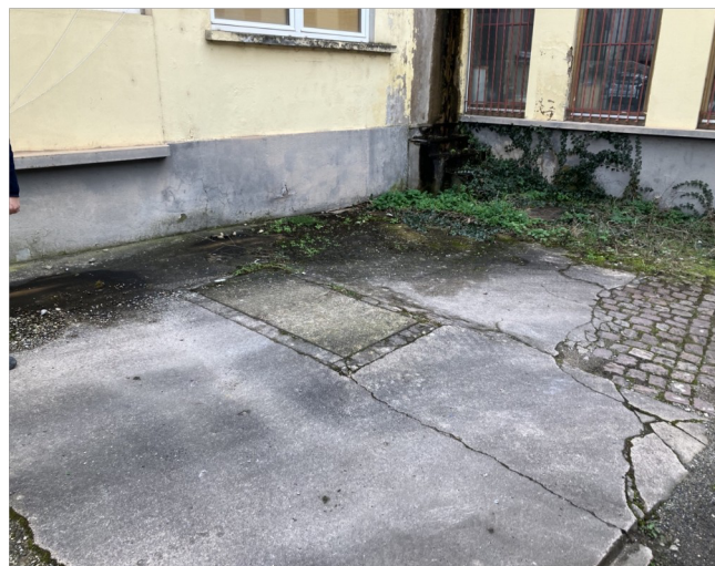
Photographie 8 : Possible cuve/fosse au sud du site
