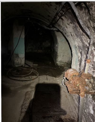
Photographie 43 : N-2 Extension ouest Pièce 86 m 2
