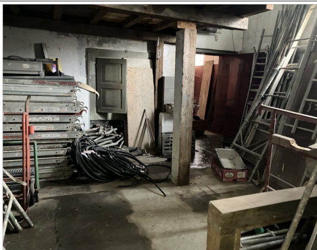
Photographie 22 : RDC – Pièce de 250 m 2 Contenant la cheminée de la chaudière
