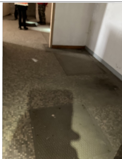
Photographie 30 : RDC – pièce de 117 m 2
