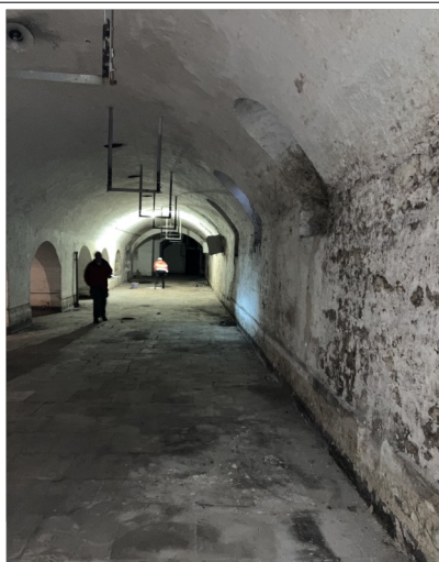
Photographie 35 : N-1 Travée Est 198 m 2
