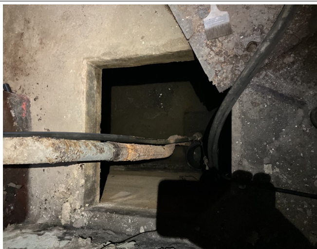
Photographie 41 : N-2 Extension ouest Pièce 86 m 2
