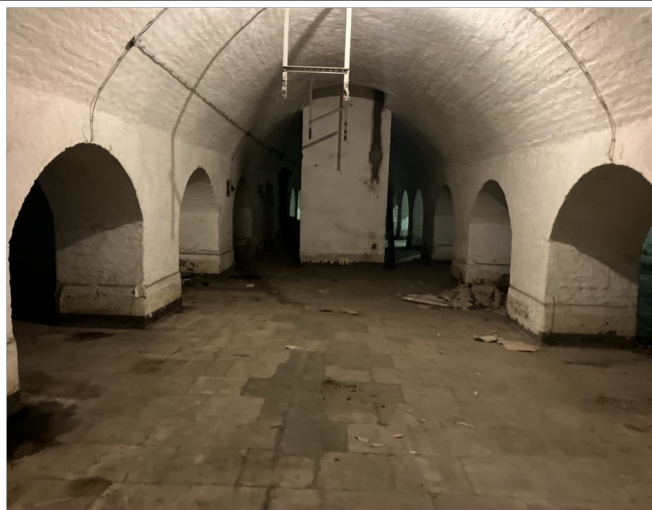
Photographie 33 : N-1 Travée centrale 185 m 2
