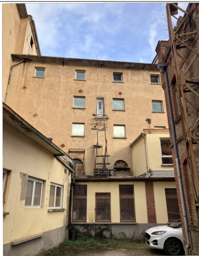
Photographie 7 : Vue vers l'est de la partie sud du site
