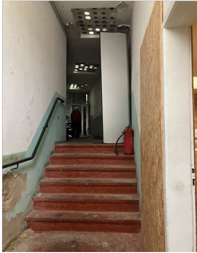
Photographie 13 : Couloir d'entrée, partie sud de l'extension ouest
