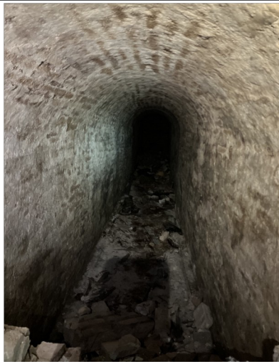
Photographie 48 : N-2 Extension ouest – pièce 83 m 2
