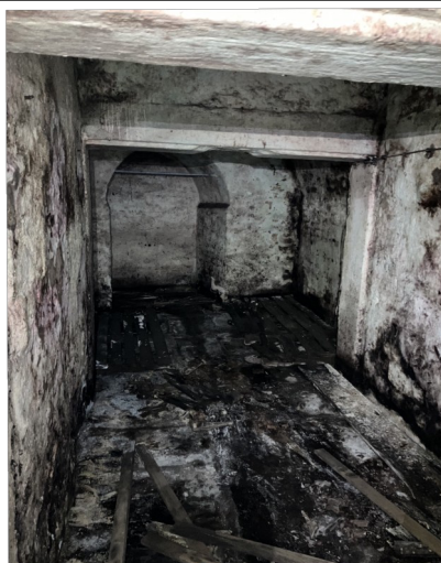
Photographie 47 : N-2 Extension ouest – pièce 83 m 2
