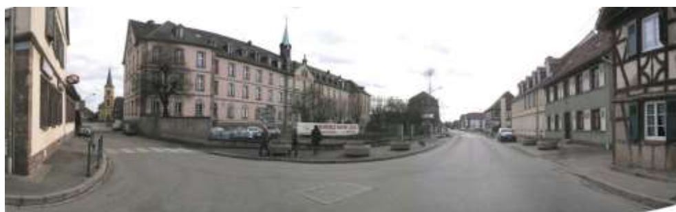
Rupture d'échelle des bâtiments du collège Saint-Joseph.
