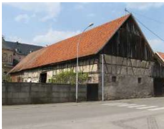
Exemple de corps de ferme pouvant être réhabilités
