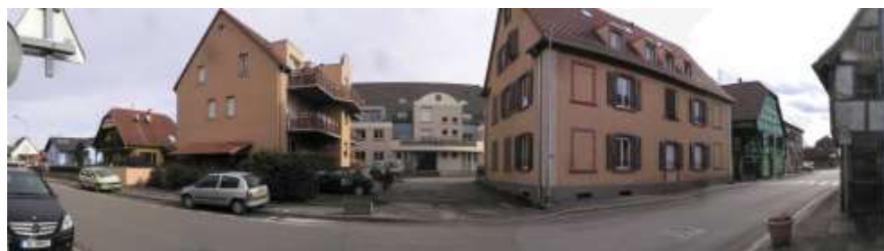
Rupture d'échelle du bâtiment d'habitation collectif récent.
