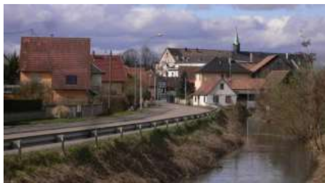
Glissière de sécurité masquant la présence du cours d'eau
