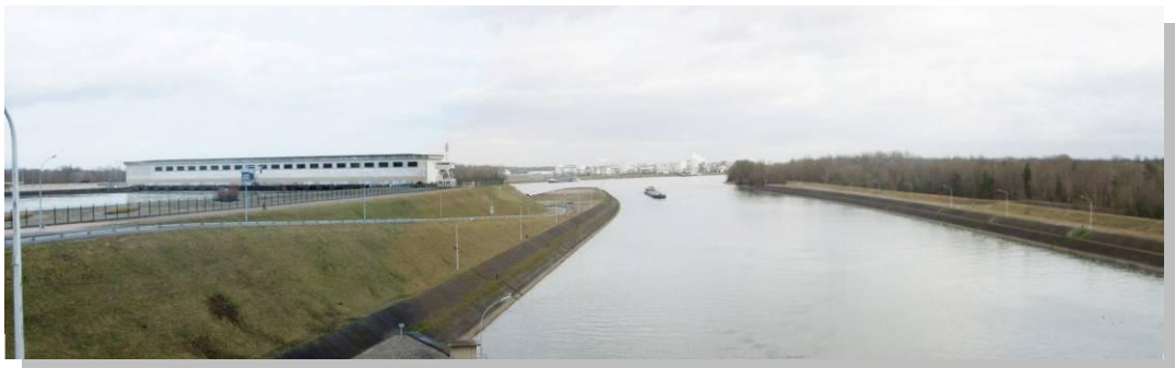
Perspective sur l'usine hydroélectrique et le Rhin canalisé
