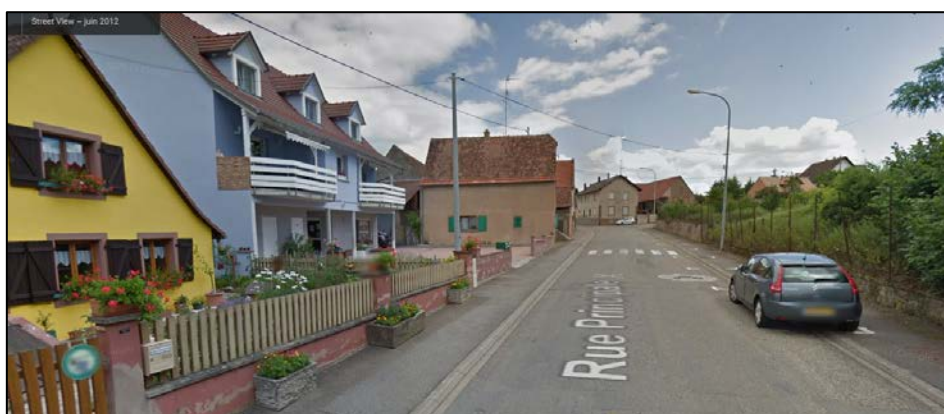
Photo 1 : mur bahut surmonté d'une clôture bois ; mur bahut de hauteur différente surmonté d'un grillage
