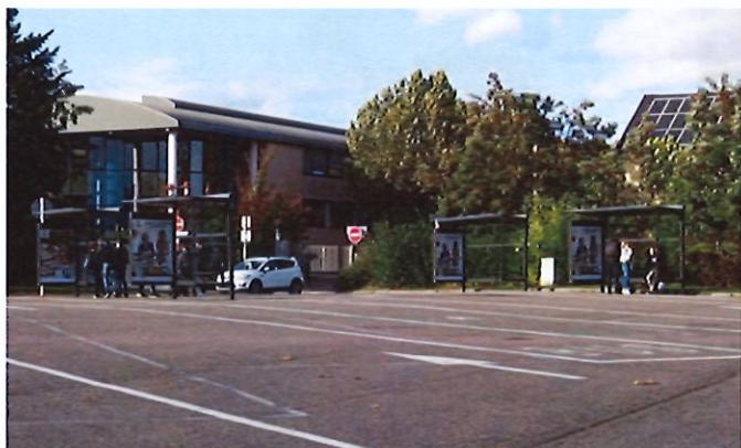
Abris voyageurs à la gare routière
