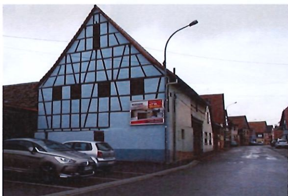
Altération de l'architecture traditionnelle
