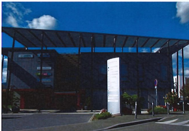
Enseigne non conforme au RLP
