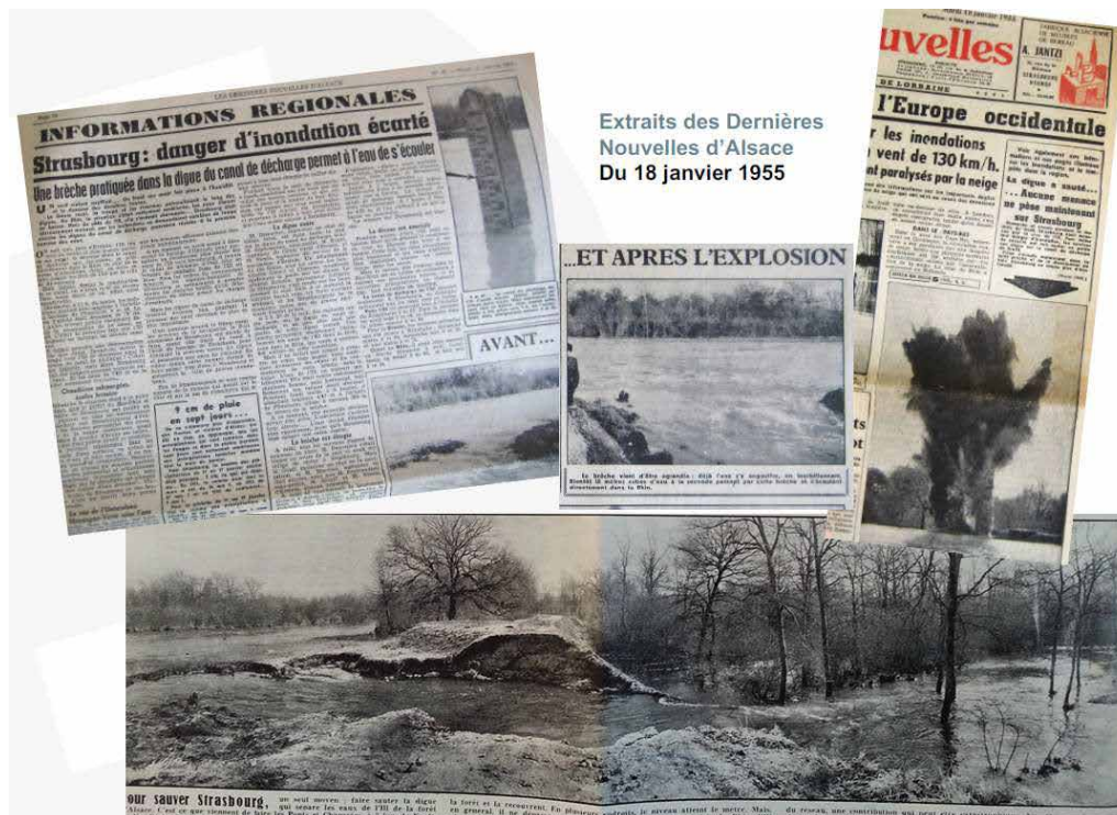
Figure 9 : Extraits des Dernières Nouvelles d'Alsace du 18 janvier 1955. Création d'une brèche dans le canal de décharge de l'III. Source : Dernières Nouvelles d'Alsace
