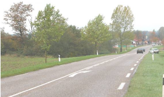
Vue depuis le Sud
