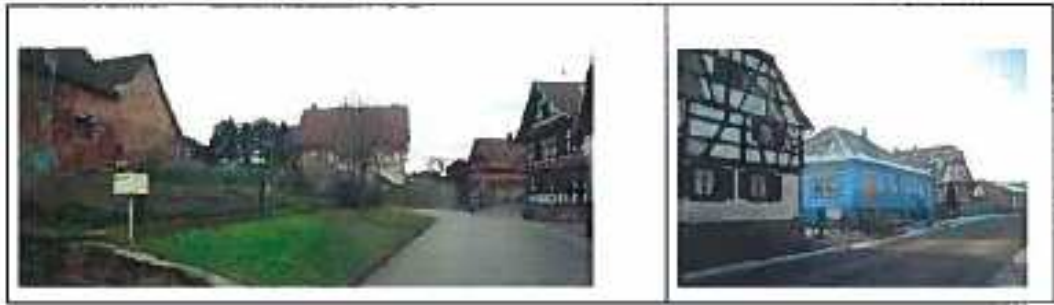
Photo 10a et b: Exemples de mauvaise gestion de la topographie et typologie du bâti non respectée
