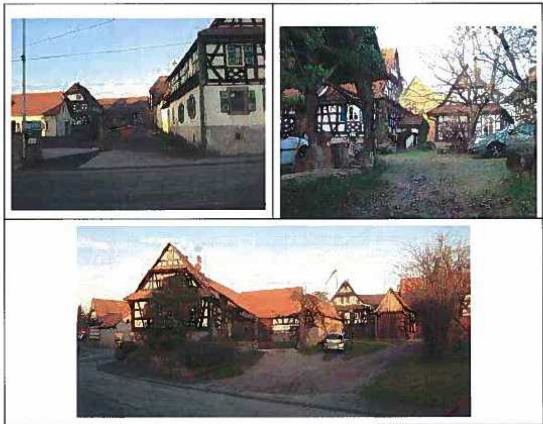
Photo 21 : Le bâti traditionnel de Keffenach
