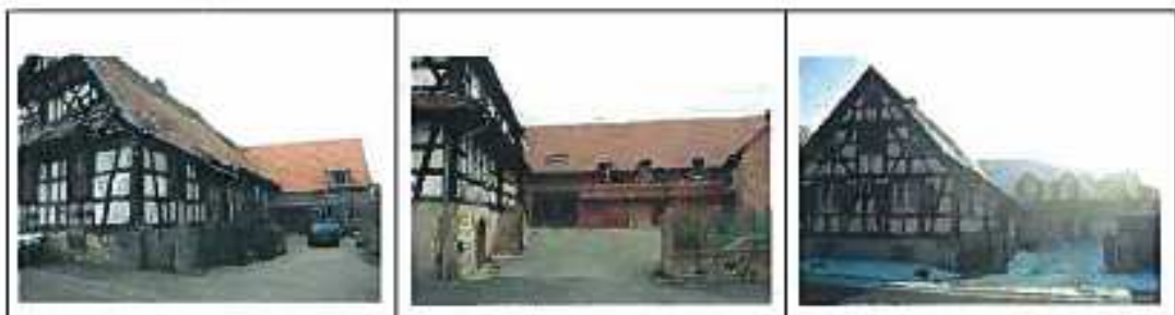
Photo 12 a, b et c : Exemples de réhabilitation de granges en logements
