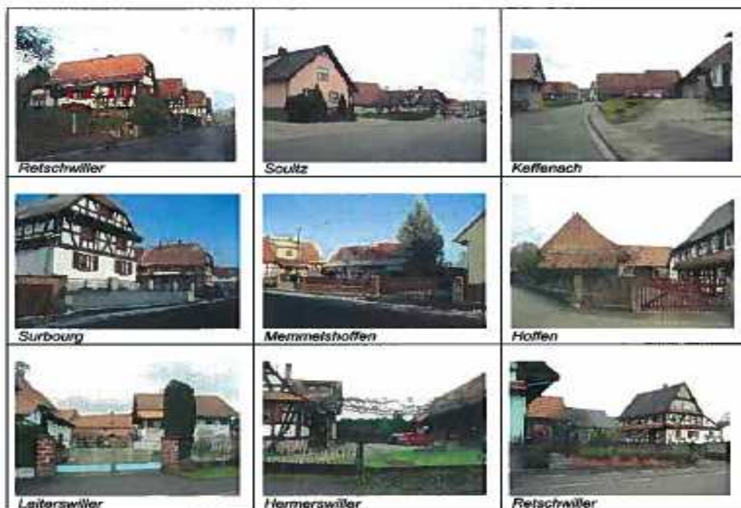
Photo 8: Exemples de bâti traditionnel peu dense
