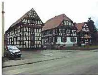
Photo 4 : Grange-séchoir à tabac à Surbourg
