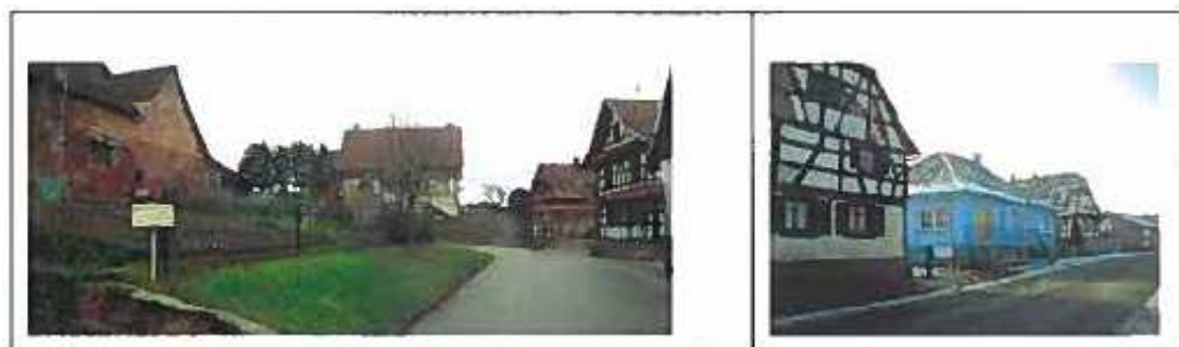
Photo 8aetb : Mauvaise gestion de la topographie et typologie du bâti non respectée
