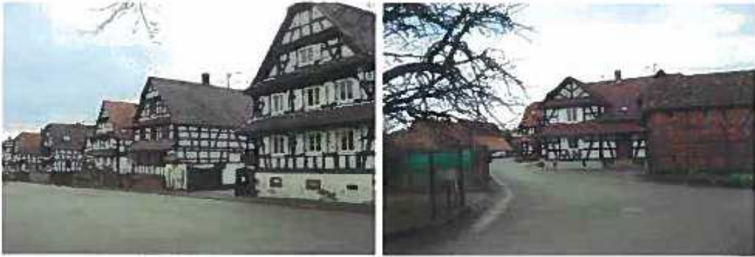
Photo 11 : le bâti ancien, traditionnel à Hoffen
