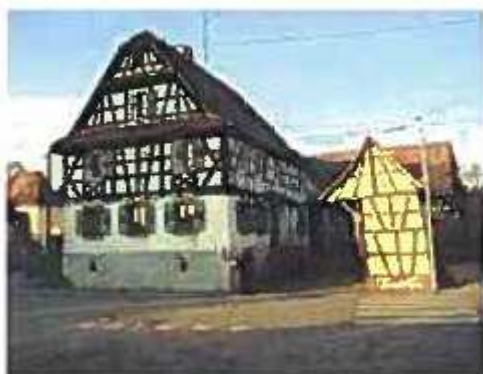
Photo 2 : Maison type vers 1800 à Keffenach Mommelshoffen
