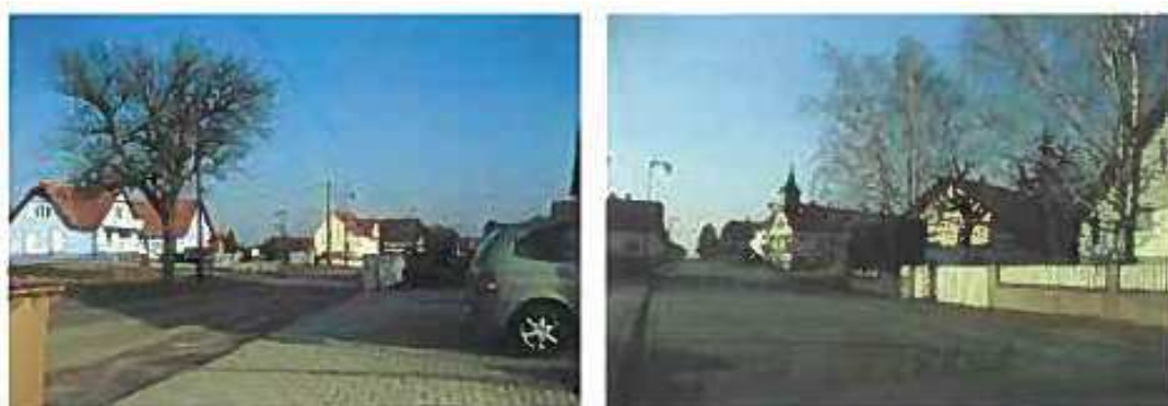
Photo 18 a et b : entrées Ouest et Est dans Hermerswiller
