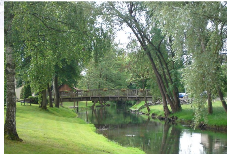
Pont piétonnier au-dessus de la Zembs
