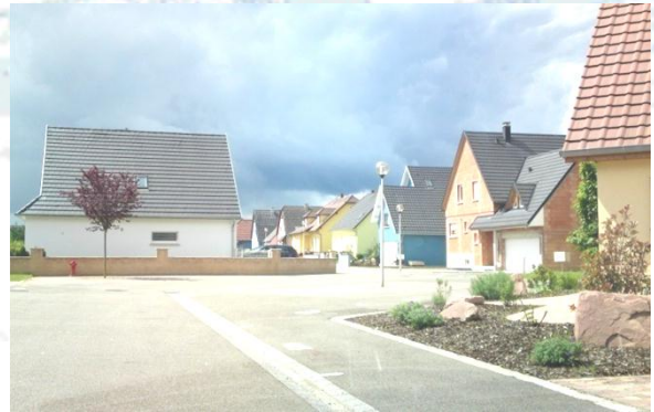
Rue des Fresnes :
