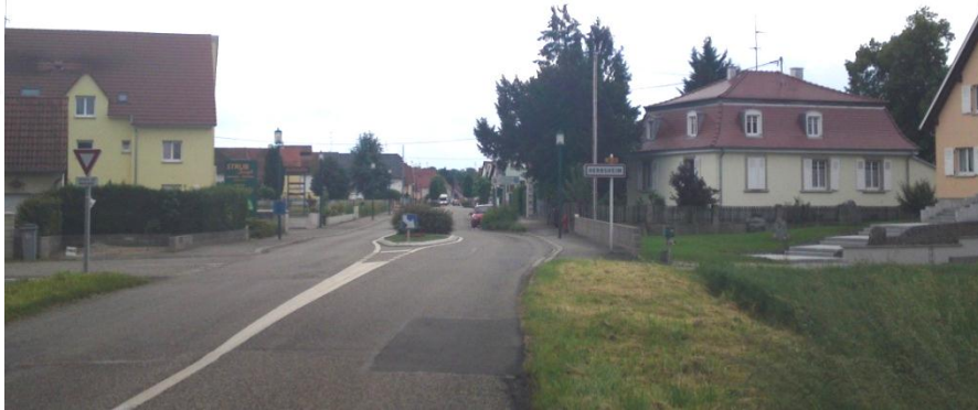
Entrée Ouest du village depuis la RD 5
