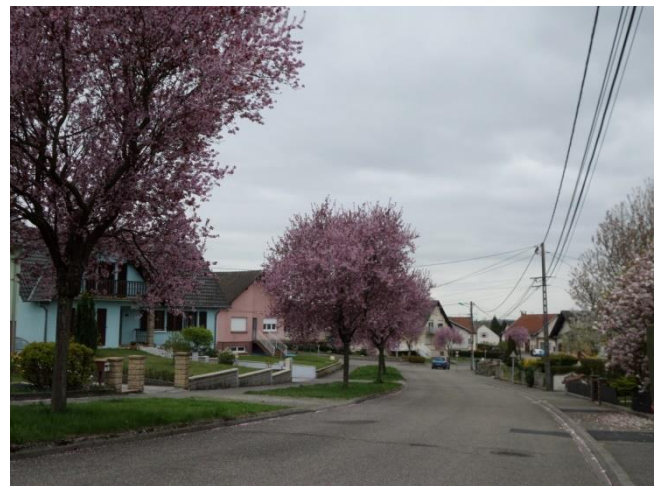
Aménagement de la voirie, rue des Mésanges
