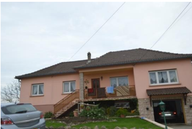
Construction isolée sur parcelle
