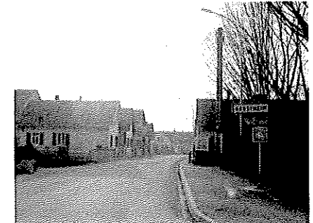
Entrée Est – RD 924
