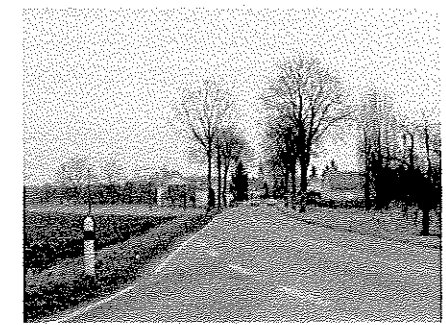
Entrée Sud – RD 468
