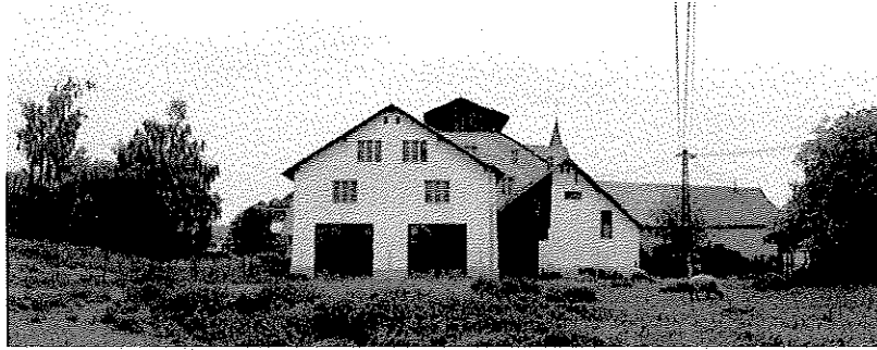
Le Moulin, vu depuis l'est
