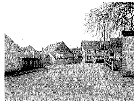
Le pont sur le rivière rue du Rhin
