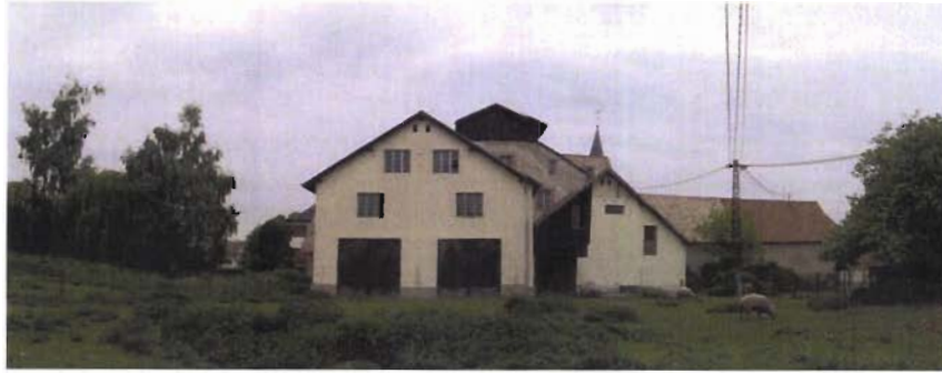
Le Moulin, vu depuis l'est
