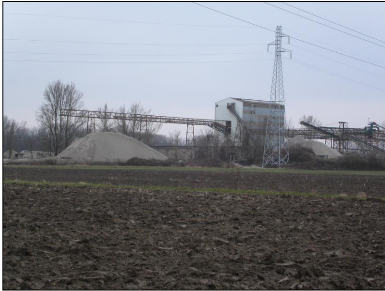
Photo 3 : Les bâtiments d'exploitation de la gravière
