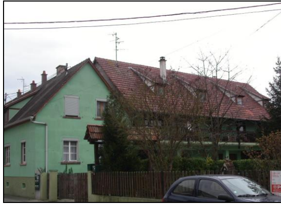
Photo 8 : Une grange réhabilitée en logements, rue du fond
