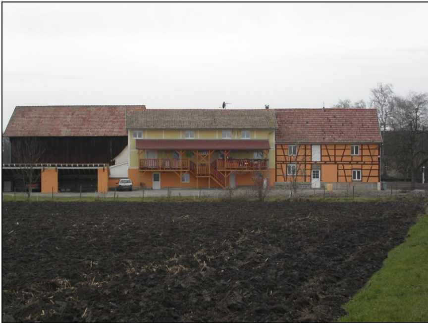
Photo 19 : Une dépendance agricole réhabilitée
