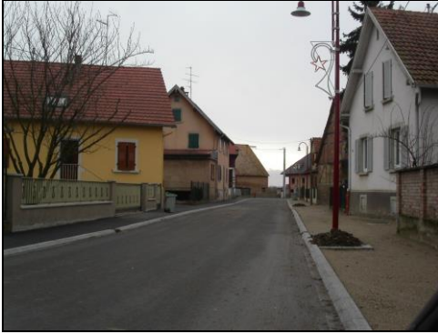
Photo 17 : Les maisons dans le virage
