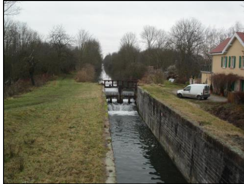
Photo 24 : l'écluse sur le Canal du Rhône au Rhin
