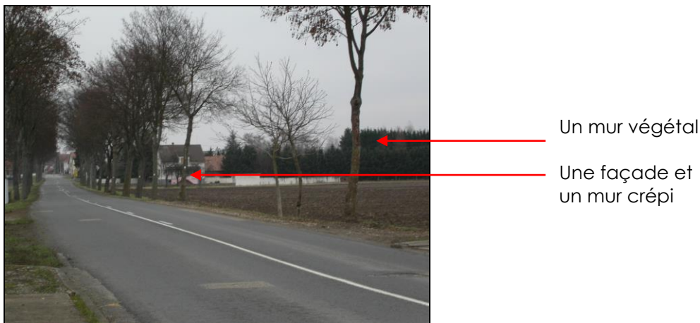
Photo 20 : L'entrée Sud de Friesenheim
