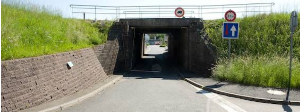
Passage sous la voie ferrée (rue des Glacières)
