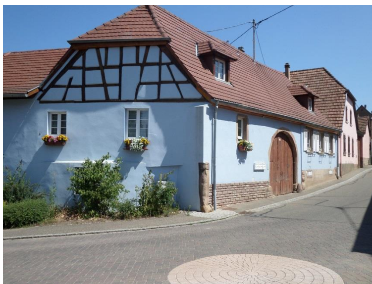
Exemple de réhabilitation d'une ancienne ferme en logements collectifs
