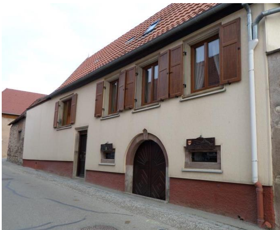
Exemple de réhabilitation avec isolation extérieure
