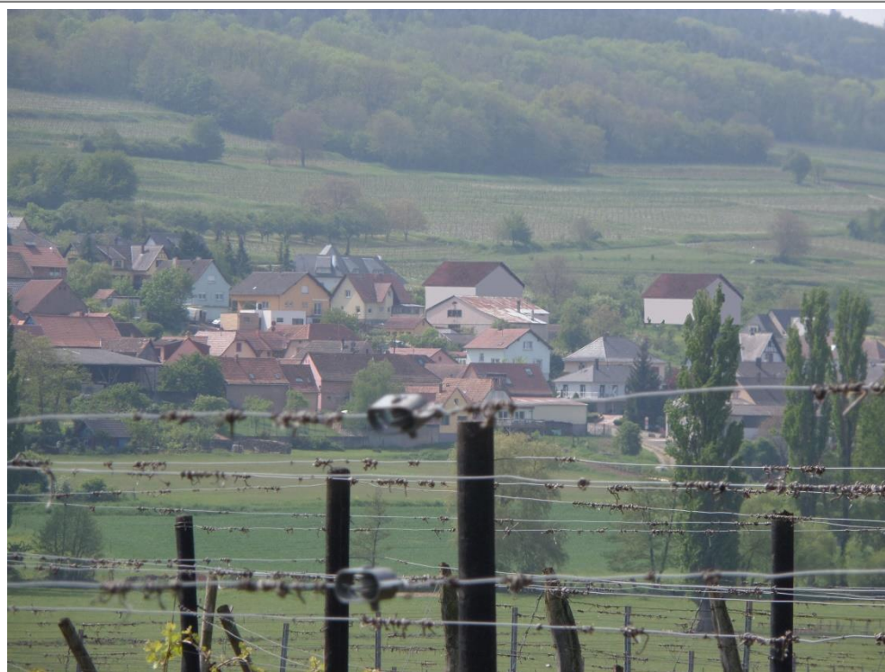
Faitage perpendiculaire à la rue – Rue Haute - Impact visuel fort
