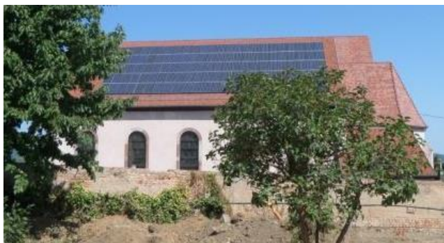
Panneaux photovoltaïques en toiture de l'église
