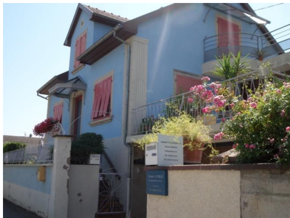
Construction des années 1950
