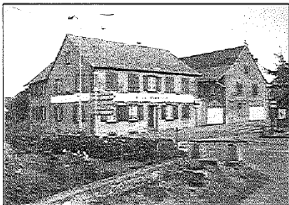
Extensions le long des voies existantes 15 route de Saint Léonard
