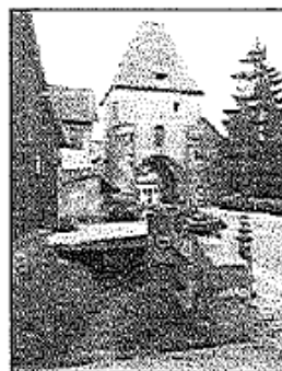
2. Entrée est de la cité
