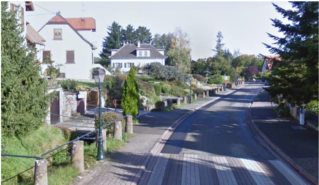
Google Street View – Route de Saint-Léonard – Présence du canal de l'Ehn devant les habitations
