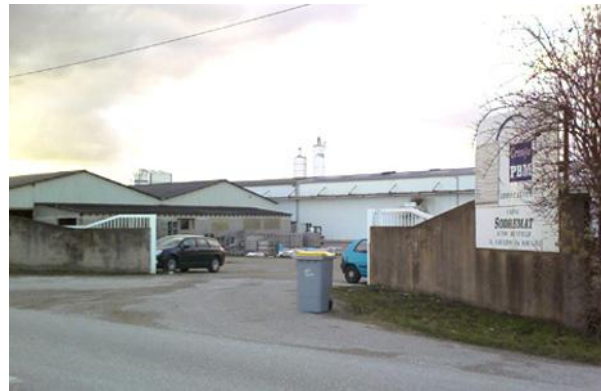
RD 282 – Préfabrication béton / ets PPM
