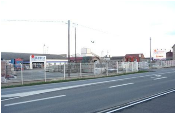
Rue du Faubourg du Rhin – Matériaux de construction
