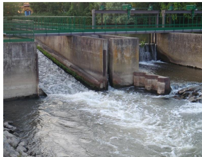
A gauche la passe à anguille et à sa droite une passe à bassins successifs (construction entre 1992 et 1996).
