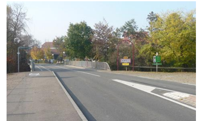
Rue du Faubourg du Rhin (RD 5) depuis Herbsheim
