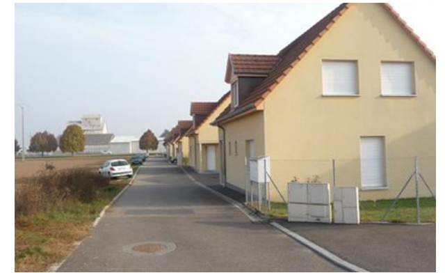
Rue du Piémont
