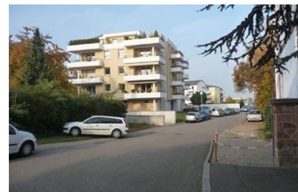
Rue des Escarpins
