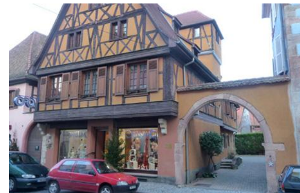
Rue du Général de Gaulle – Maison d'Andlau
