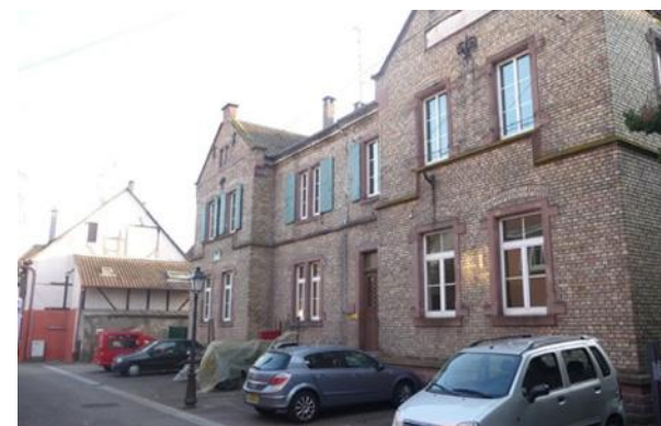
Ecole de musique – rue du Châtelet
