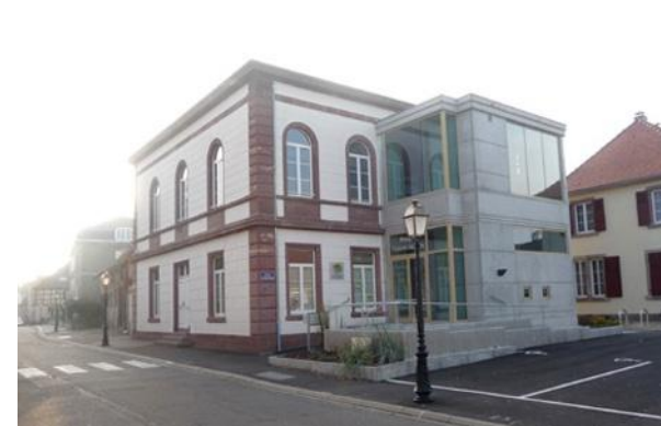
Maison intercommunale des associations – rue du Château
