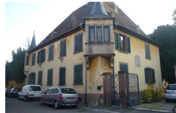
Rue du Châtelet – Maison Le Châtelet
