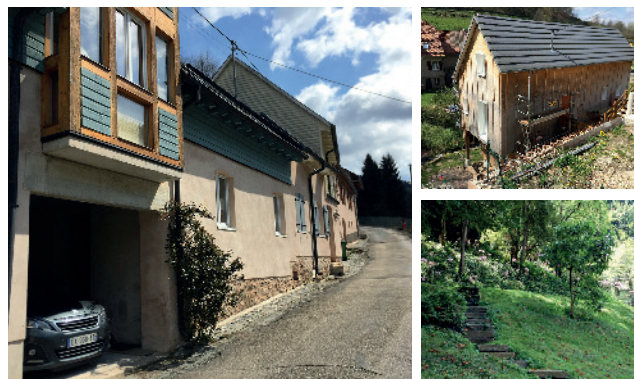
La construction sur pilotis, ici à Zittersheim, (arch. Wisser-Demoulin) est une réponse d'implantation intéressante pour limiter les terrassements.
