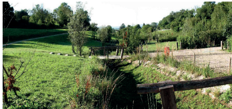
Les plates-bandes enherbées ou plantées d'espèces variées permettent d'infiltrer ou de stocker les eaux de pluie
