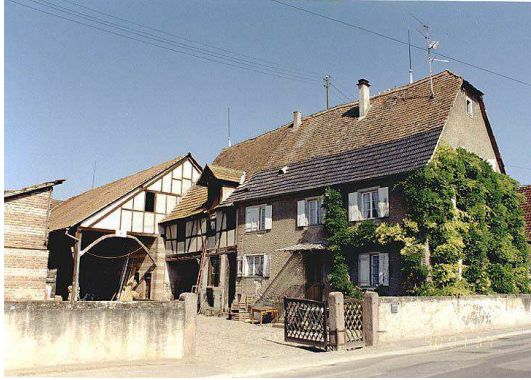
Ferme - 3 rue de Sélestat
