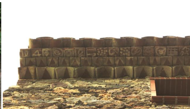
Avant-toit en tuiles de terre cuite peintes
