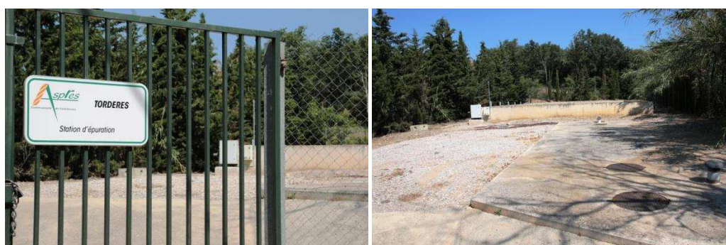
Site de la station d'épuration de Tordères.
