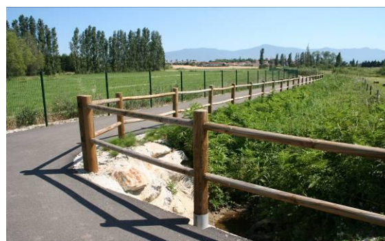
Photo 64 : Cheminement de la Mitjaïgue
