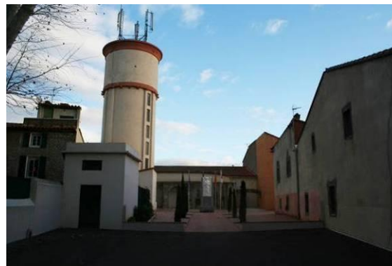
Photo 79 : Placette du Monument au Mort
