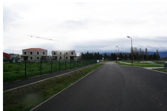
Photo 81: Cheminement espace public
