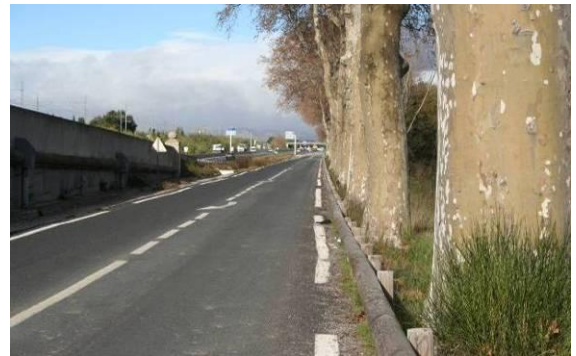
Photo 59:Voie longeant le RD 914
