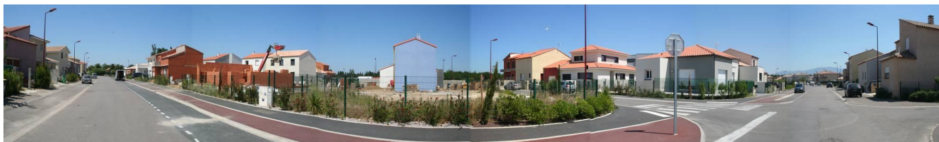
Photo 19 : Voie de desserte entre « 15 Olius » et « Oratori » au Nord
