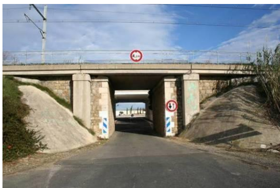
Photo 61: Tunnel sous la voie ferrée
