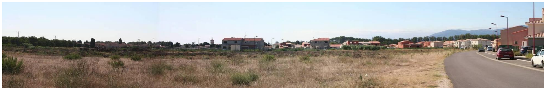
Photo 18: Début de chantier lotissement « Oratori » en 2012 et constructions des « 15 Olius »
