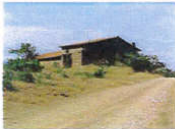
Bâti agricole traditionnel au lieu dit « las Oulvetas »
