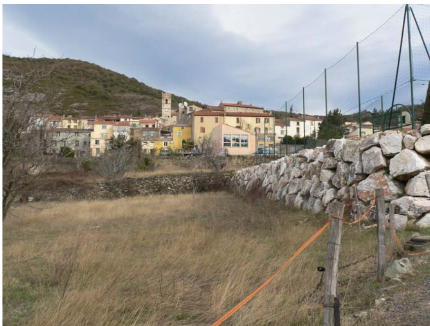
3 Masse bâtie du village et terrasses soutenues par des murets en pierre sèche.
