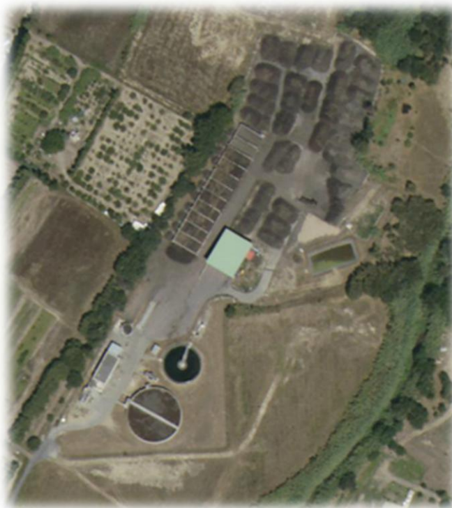
☞ Photographie 4 : Vue aérienne de la station d'épuration de Saint André et de la plateforme de co-compostage attenante (Géoportail)
