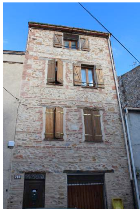
La hauteur des bâtiments est de maximum R+3 dans le village.
