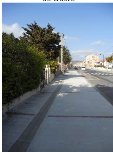
Aménagements répondant aux conditions d'accessibilité à proximité des écoles sur l'avenue de Gaulle
