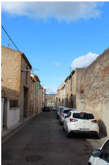
Dans le village, les rues sont marquées par des bâtisses, murs en pierres, granges agricoles, alignées en front de rue.
