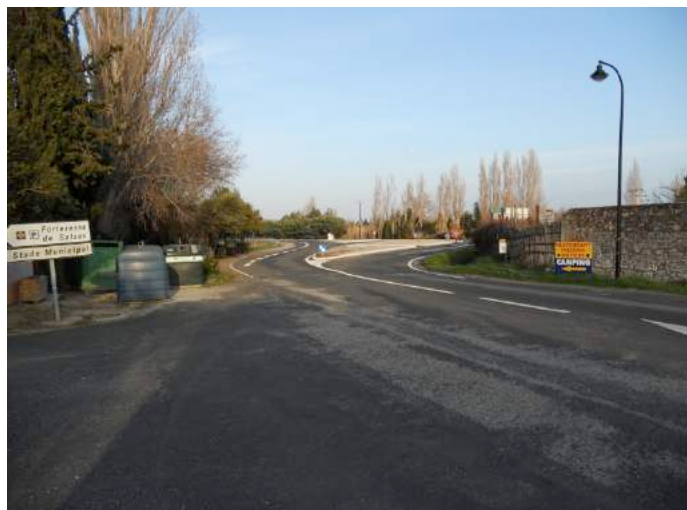
Embranchement d'accès au parking de la forteresse de Salses
