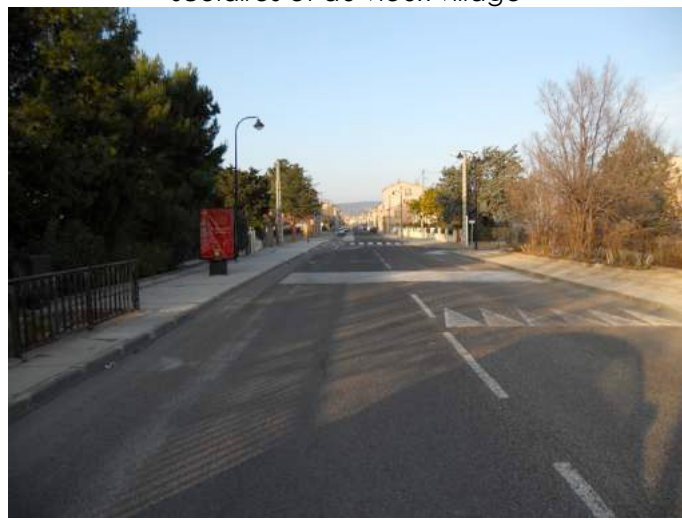
L'entrée de ville depuis le pont sur l'Avenue de Catalogne en direction du Nord et des groupes scolaires et du vieux village
