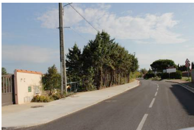
Création de trottoirs sur un côté par busage d'un canal
