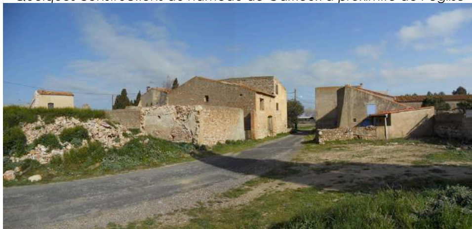
Quelques constructions du hameau de Garrieux à proximité de l'église
