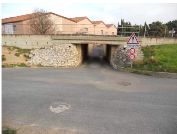
Le passage souterrain depuis le Cami del paroll, côté Forteresse
