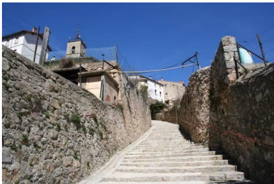
Photo 69 : La Pujada de la RD3 vers le centre ancien
