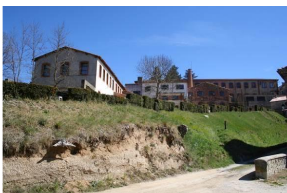
Photo 19 : Bâtiments industriels traditionnels
