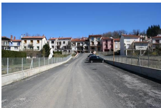
Photo 72 : Stationnement aménagé entre la Quère et l'avenue Guillaume Julia
