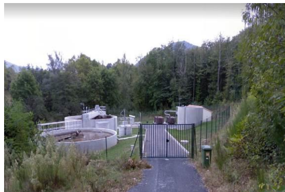
Photo 83 : La station d'épuration
