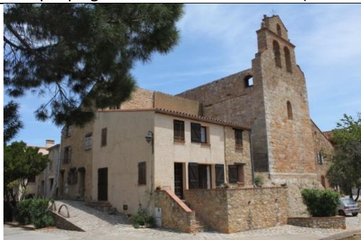
Vue de l'église et constructions attenantes matérialisant la première cellera
