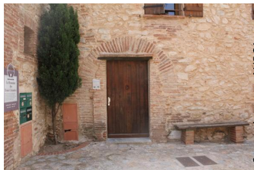
Détail entrée maison de ville, traces d'une ancienne porte encadrée par des cayrous
