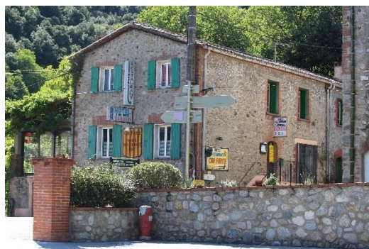
Photo 101 : « Can Fouste » au Pont
