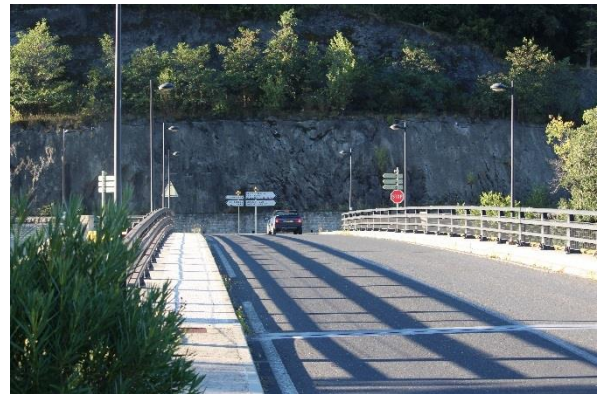
Photo 62 : RD15 et trottoirs sur le nouveau pont en provenance du secteur Vila / Palmère
