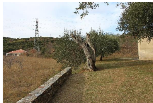
Photo 95 : Pylône de la ligne « Aspres – Céret » près de la chapelle Saint-Paul
