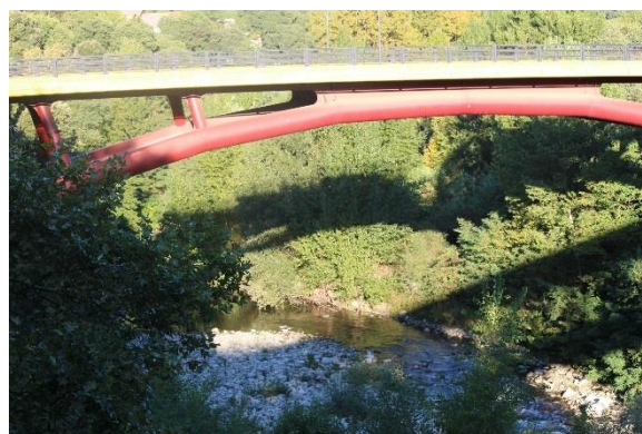
Photo 49 : Le Tech sous le nouveau pont en septembre 2017
