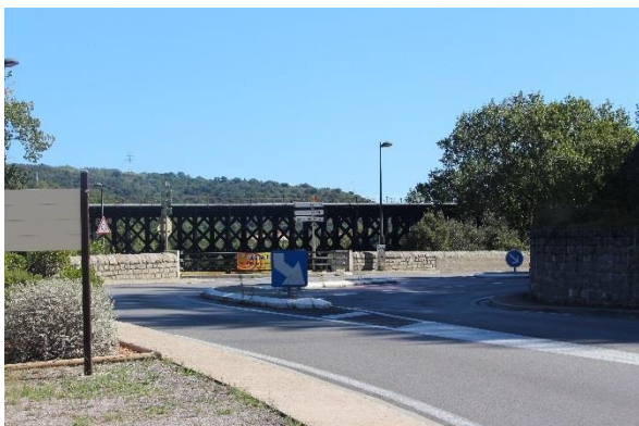
Photo 60 : Jonction entre la RD115 et la RD15 au niveau du Pont
