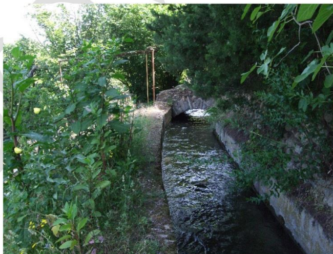
■ Photographies 7 : Canal du Secteur La Forge au droit des potagers
