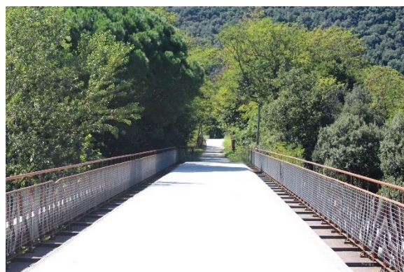
Photo 9 : L'ancienne voie ferrée devenue voie verte au-dessus de la RD115
