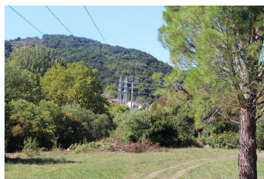
Photo 96 : Pylônes au niveau du poste d'enceinte de Céret
