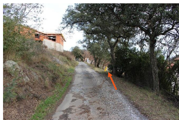
Photo 108 : Canalisation de gaz à la Palmère
