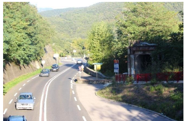
Photo 23 : Le RD115 et les 2 ponts
