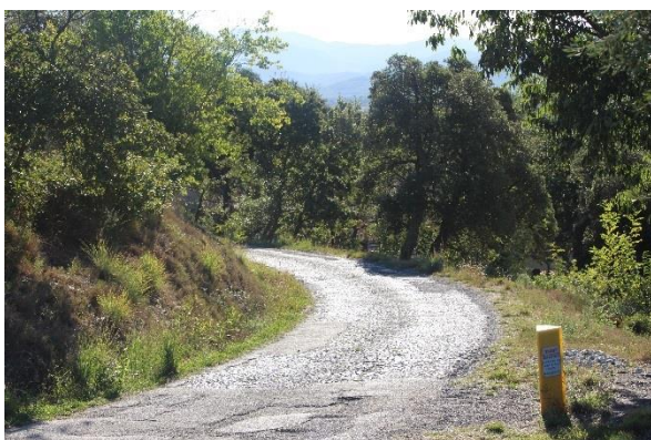
Photo 67 : Voie communale n°9 ou route de la Palmère
