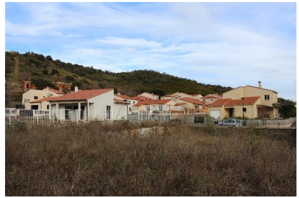
Photo 20 : Finalisation du lotissement de la « Soulane »
