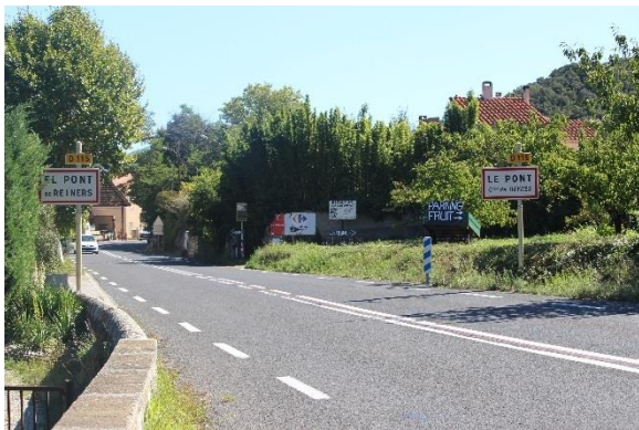
Photo 17 : Entrée dans le « Pont » en provenance de la Forge et d'Amélie-les Bains
