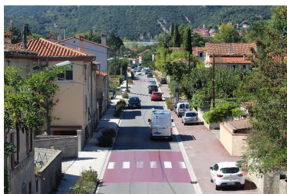
Photo 76 : Stationnement avec marquage associé au trottoir à la Forge
