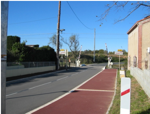
RD 49 A U FRANCHISSEMENT SNCF
