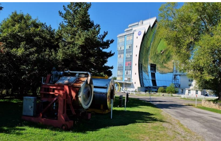
Four solaire Odeillo
