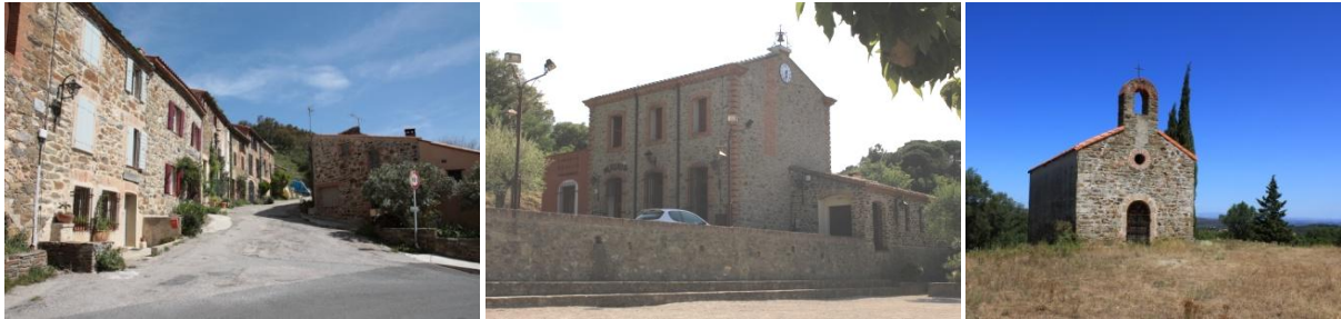
Bâti traditionnel et éléments patrimoniaux à Montauriol (source : AURCA)
