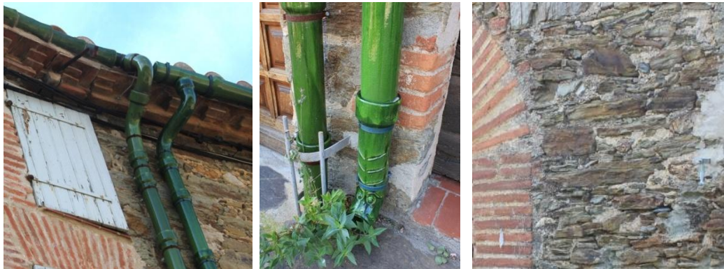
De gauche à droite : « Tortugada » : chéneaux en terre cuite vernissée de couleur verte. On la trouve parfois peinte en jaune/ Canalisation pluviale en terre cuite vernissée de couleur verte/ Mur en pierres et cayrou
