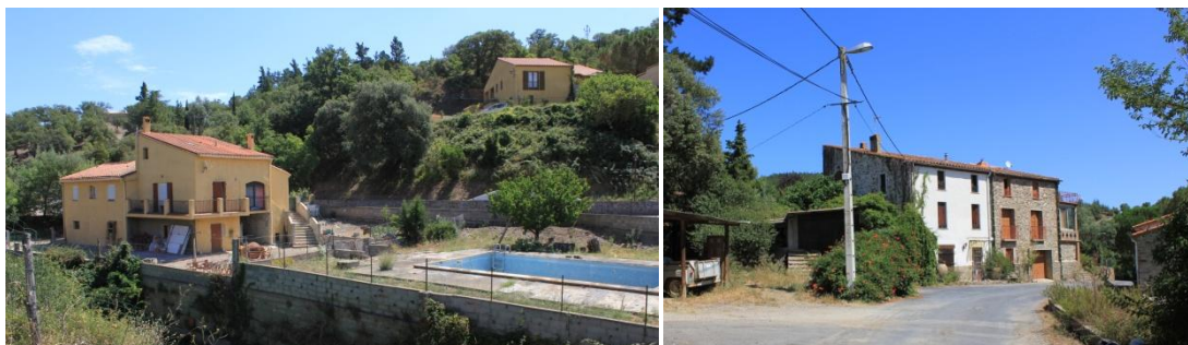
De gauche à droite : Maison en entrée de village non intégrée dans le paysage et réseaux aériens devant veïnat
