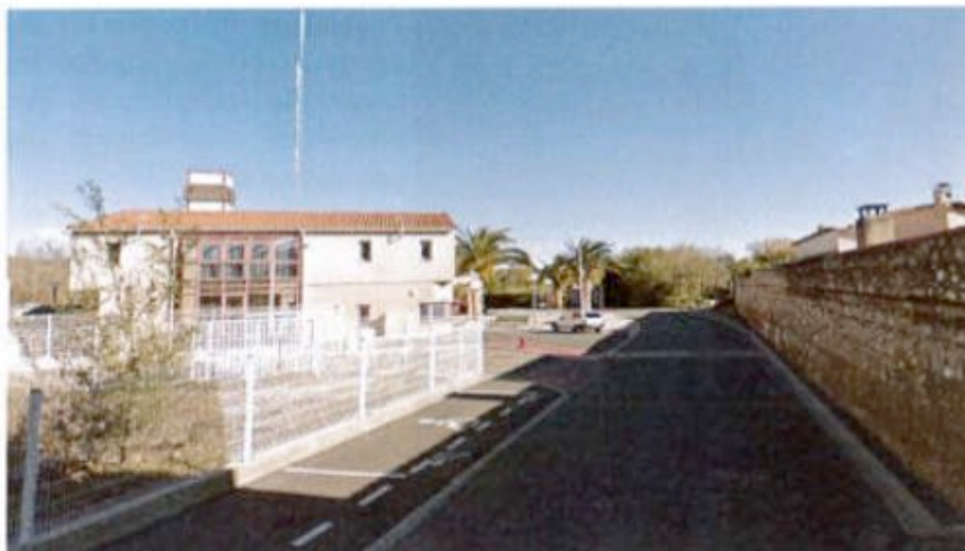
Le mur chemin du Tournail – www.google/streetview.fr
