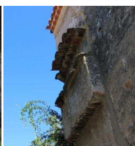
Vestiges d'un four à pain
