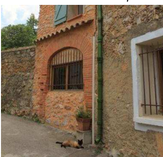
Mur en pierres et encadrement de porte en cayrou
