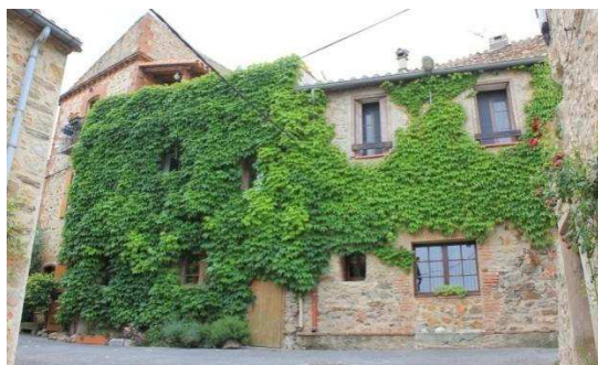
Végétation intégrée au bâtiment
