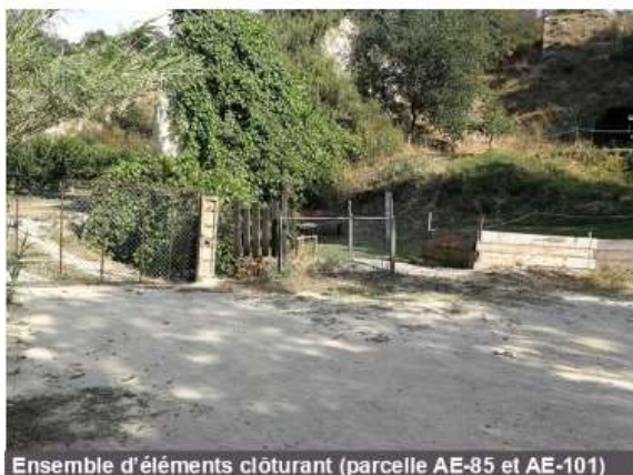
Ensemble d'éléments clôturant (parcelle AE-85 et AE-101)
