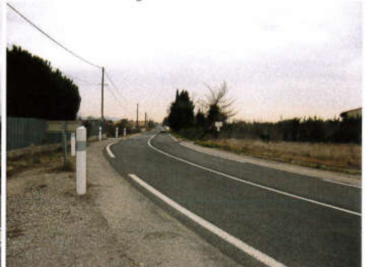
Vue de la ligne droite vers le centre.
