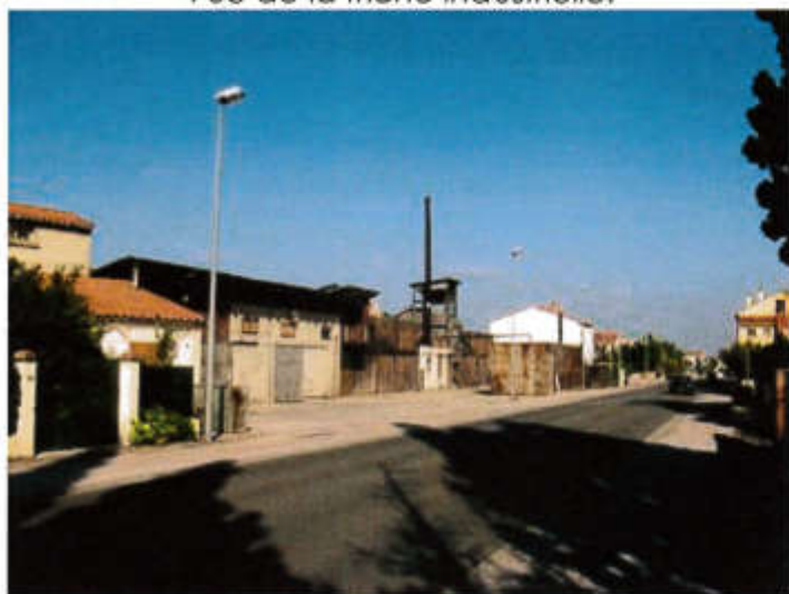
Vue de la friche industrielle.
