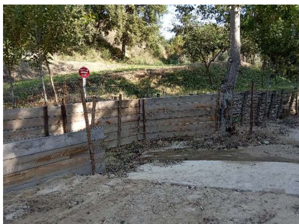
Déviation et clôture du ruisseau
