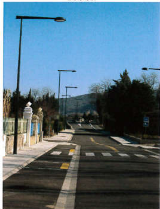
Aménagement pour le franchissement du Boulès.
