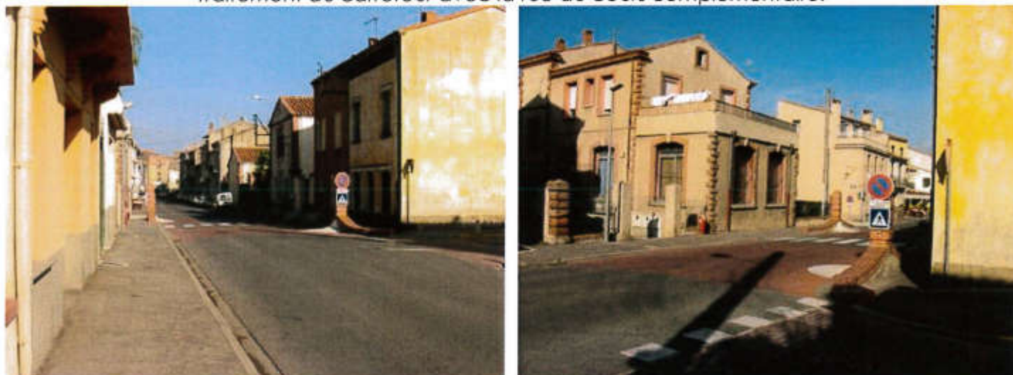
Traitement du carrefour avec la rue du cours complémentaire.
