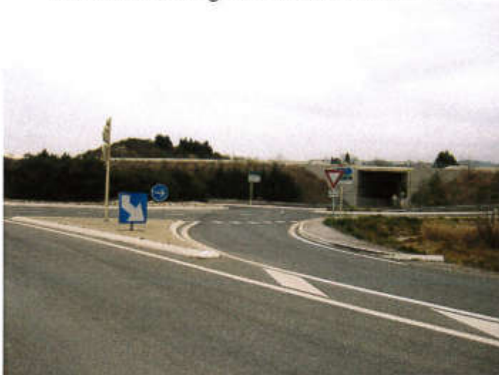
Vue de l'échangeur Ouest de la RN 116.
