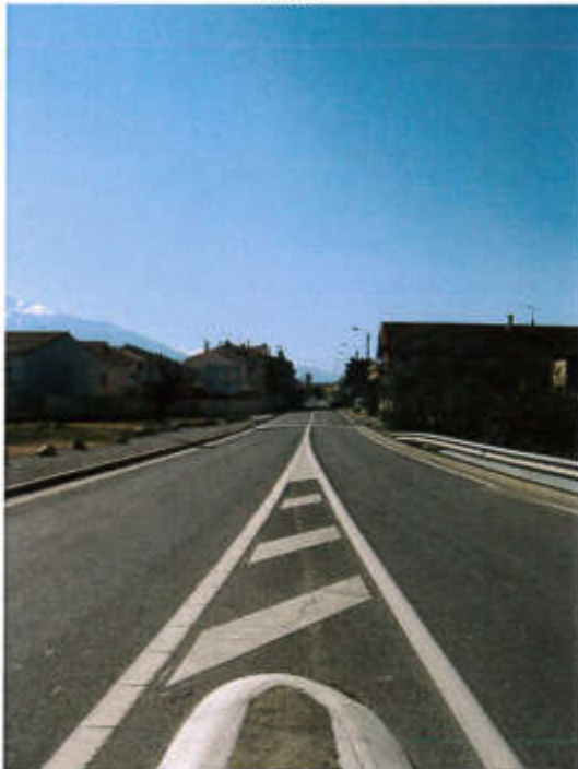
Vue depuis le premier giratoire vers le centre-ville.
