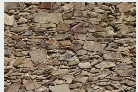
Jujols - murs de moellons en schiste
