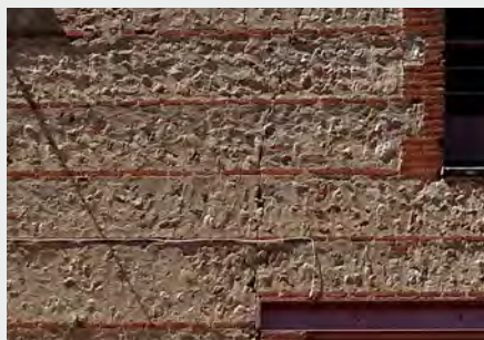
Saleilles - murs de moellons avec une assise en brique
