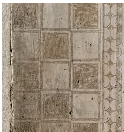
Chaîne d'angle en enduit sgraffite
