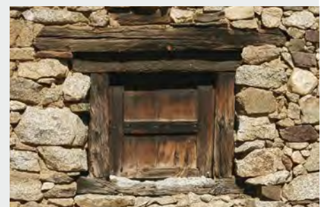
Fenestrou - linteau et encadrement en bois
