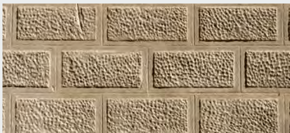
Enduit imitation en pierre de taille avec effet de bossage
