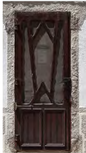
Laroque-des-Albères Porte vitrée équipée d'une moustiquaires ouvragée
