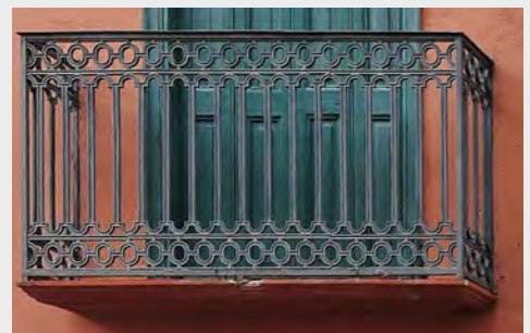
Garde-corps en fonte
