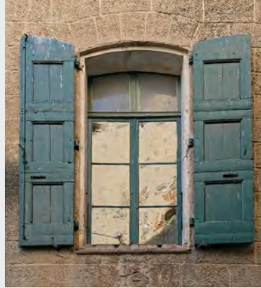
Fenêtre à petit-bois avec une imposte fixe vitrée. Encadrement à feuillure. Contrevent à cadre.
