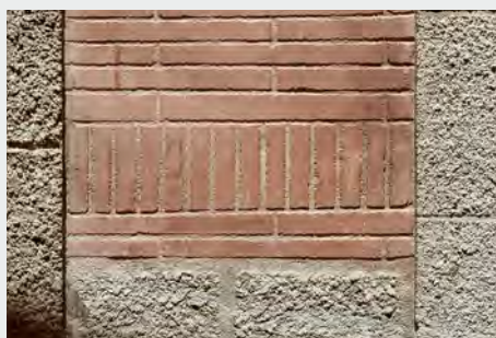
Deux exemples d'enduit sculpté imitation brique
