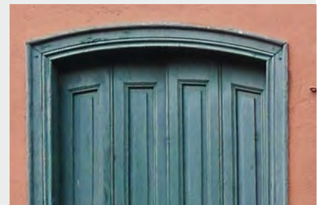
Chambranle en bois à fascies sur linteau en arc surbaissé
