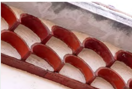
Génoise à plusieurs rangées de tuiles
