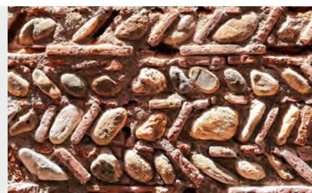
Mur mixte de galets avec inclusion et assise en cayrou
