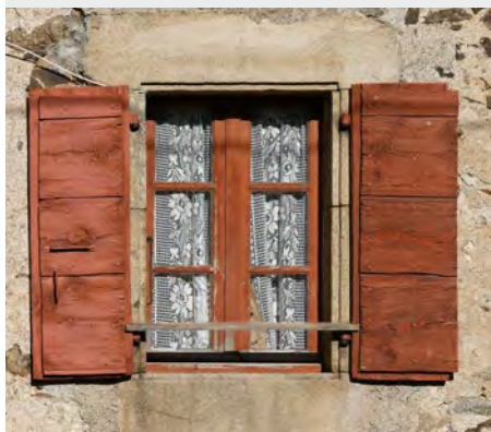
Encadrement à feuillure* en pierre de taille. Contrevent à planches horizontales jointives en face interne. Fenêtre à petit bois
