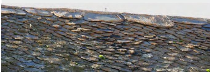
Faitage d'une toiture en llose
