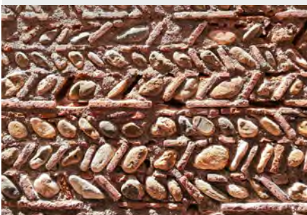
Perpignan - murs assisés avec alternance de galets et de briques
