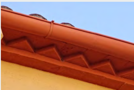
Corniche de briques agencées et/ou moulurées
