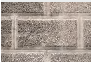
Enduit crépi avec dessin de pierre de taille
