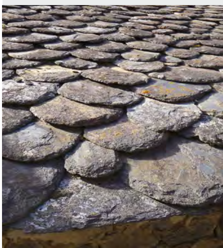
Les lloses sont taillées en écailles. La partie découverte et l'épaisseur des tuiles en llose sont de taille irrégulière.
