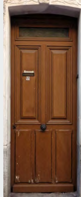
Prades - Porte à panneaux et à imposte vitrée fixe (fin 19 e siècle)
