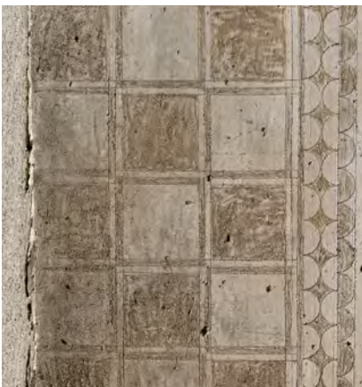
Chaîne d'angle en enduit sgraffite
