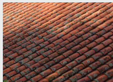
Toiture en tuile canal
