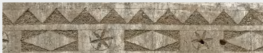
Bandeau en enduit sgraffite
