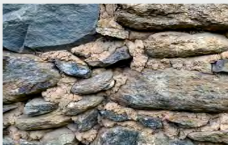
Moellon* en pierre avec hourdage en terre à Taurinya. (hourder*)
