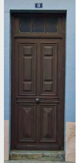
Bages - Porte début 20 e à imposte vitrée et à motif renaissance autour de la serrurerie - Panneaux en pointe de diamant en partie inférieure
