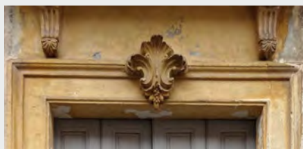
Encadrement en stuc et clé formée d'un dessin de feuille
