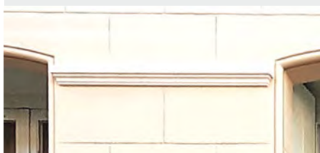
Cordon en stuc entre deux ouvertures
