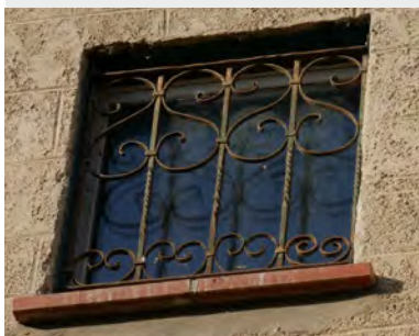
Ferronneries : grille de défense en fer forgé
