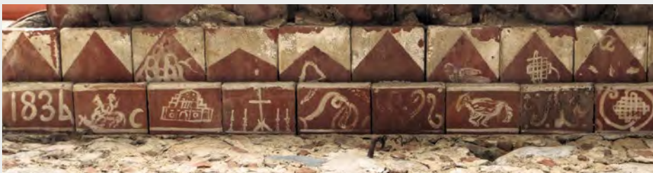
Sous-face de corniche peinte. C'est une spécificité catalane et majorquine. On ignore l'origine de ces décors peints au lait de chaux. Ici, il y a un mélange de triangles et de dessins « symboliques ».
