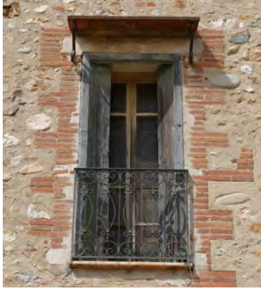
Fenêtre à deux vantaux. Encadrement en bois. Contrevents traditionnels à brisures (4 vantaux se pliant dans le sens de la hauteur).
