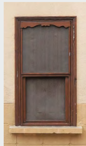
Maury - Fenêtre équipée d'une moustiquaires devant des contrevents à brisures verticales
