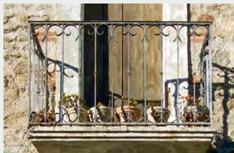
Garde-corps en fer forgé
