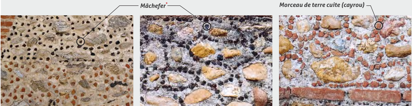
Joints avec inclusion de mâchefer* ou de terre cuite (cayrou)
