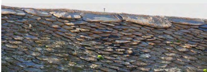
Faitage d'une toiture en llose
