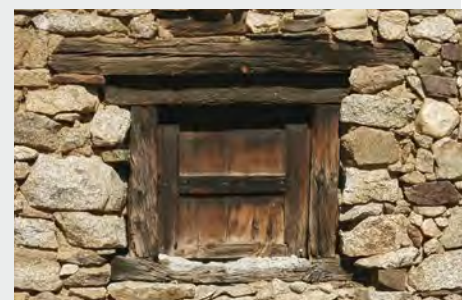
Fenestrou - linteau et encadrement en bois
