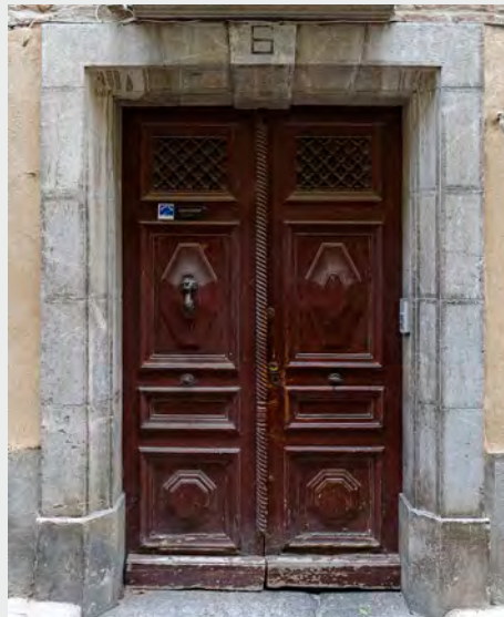
Encadrement en pierres de taille moulurées. Linteau composite en plate-bande avec clef saillante. La menuiserie du 19 e siècle à panneaux sculptés et fausse pilette torsadée est typique de la région.
