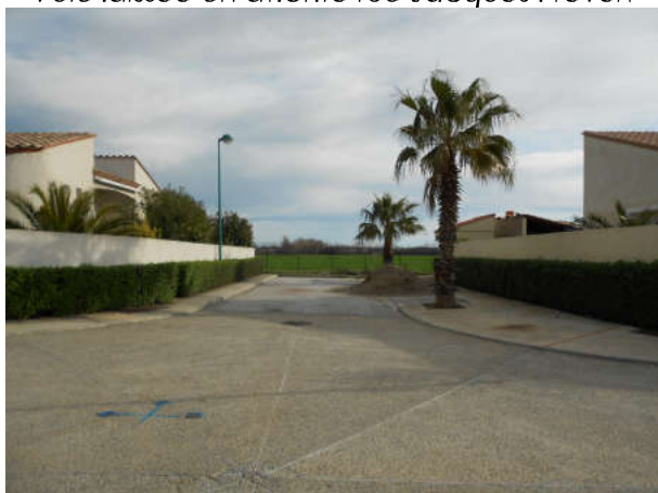
Voie laissée en attente rue Jacques Prévert
